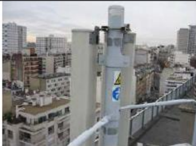
PHOTO DEPUIS LE MAT DE L'ANTENNE AZ : 110°
