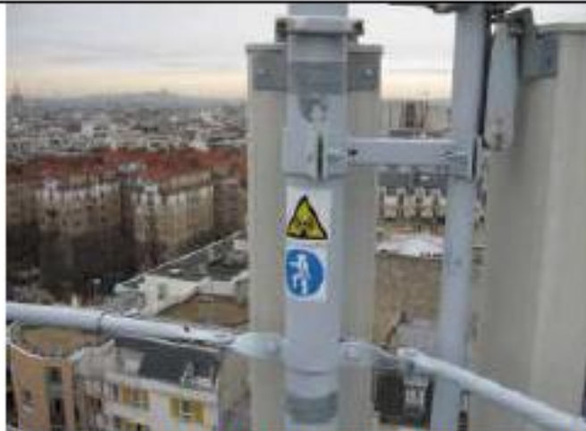
PHOTO DEPUIS LE MAT DE L'ANTENNE AZ : 30°
