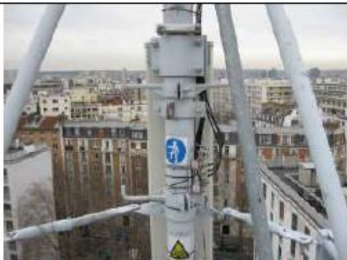
PHOTO DEPUIS LE MAT DE L'ANTENNE AZ : 240°
