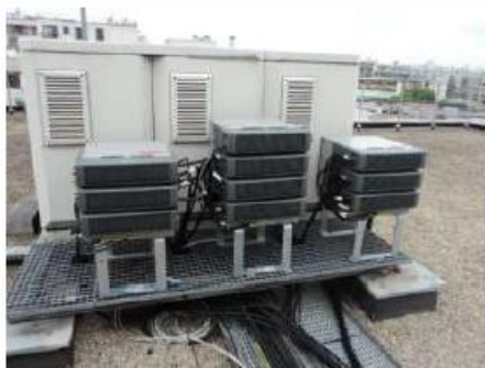
PHOTO AVANT TRAVAUX
