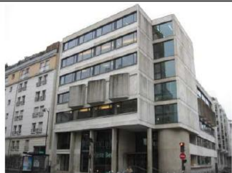
PHOTO DEPUIS LA RUE AVANT TRAVAUX
