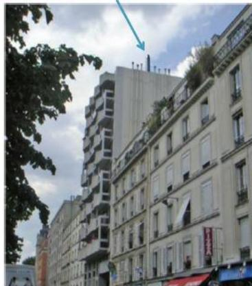
Pas de modification visuelle du bâtiment – Les antennes sont intégrées dans des radômes
