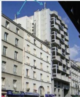
Pas de modification visuelle du bâtiment – Les antennes sont intégrées dans des radômes
