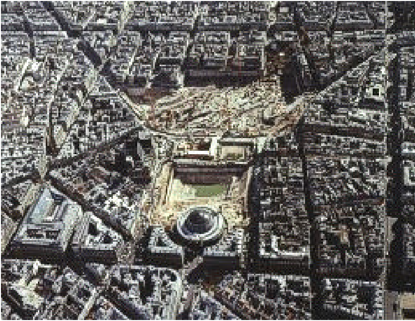
Juillet 1975. Les débuts du chantier. Source: La Documentation Française
