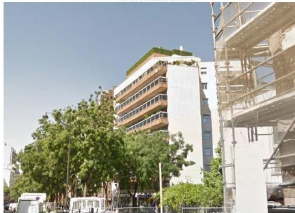
Vue du bâtiment Existant
