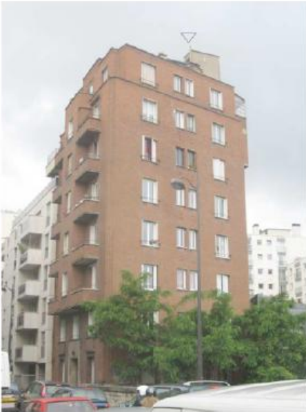
DP 7.1 - Photo de l'existant
