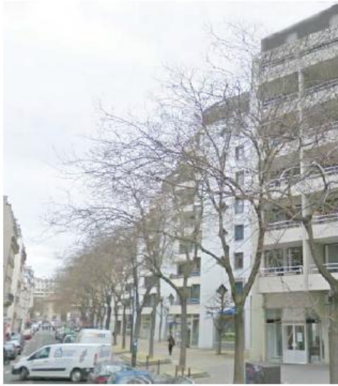
DP 7.1 - Photo de l'existant
