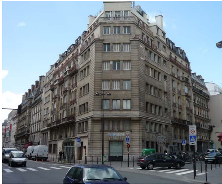
Ci-dessus, l'angle des rues La Fayette et Louis Blanc : les bâtiments de Clément-Camus de 1935 enveloppent l'immeuble de rapport de 1899 qui présente une riche façade sur la rue La Fayette.
