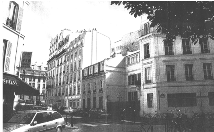
Ci-dessus : vue de la rue, et insertion paysagère lointaine du projet.
