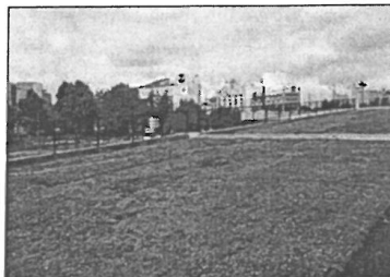
Couverture du périphérique Porte de Vanves
