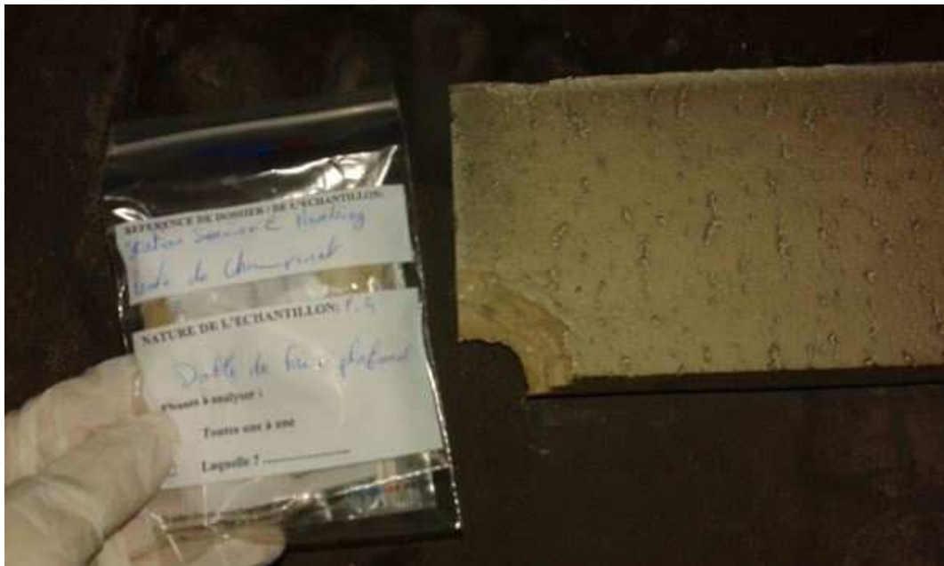
P4 - Station service 2 - Plafond - Faux plafond en dalles suspendues
