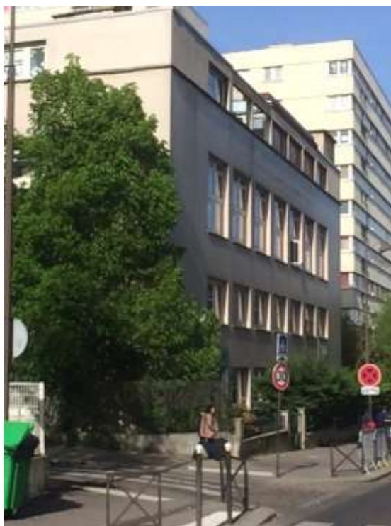
Photographie 4 : Façade principale de l'immeuble OCM-CEASIL, rue Vigée-Lebrun.
