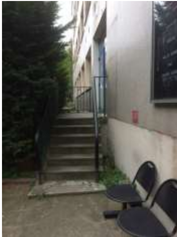
Photographie 10 : L'entrée du centre social, invisible depuis la rue et non accessible aux personnes à mobilité réduite (les fenêtres de la cour anglaise en façade s'ouvrent juste après le perron).
