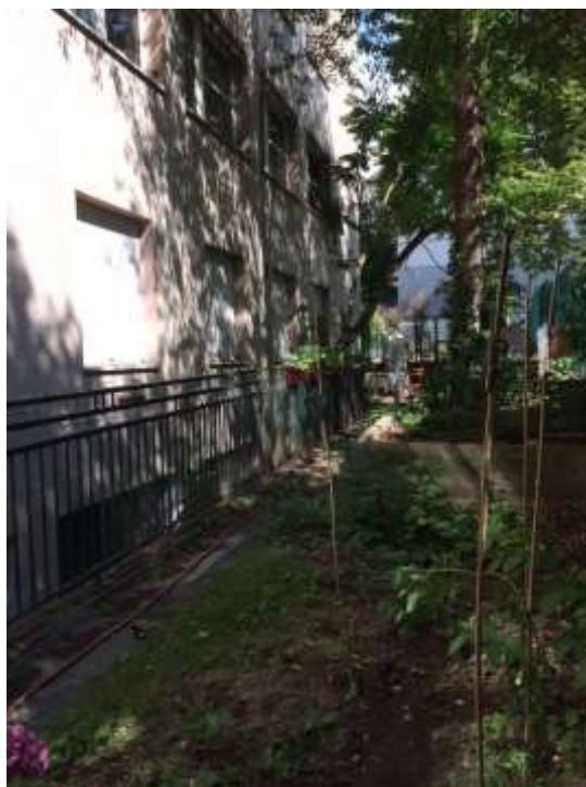
Photographie 5 : Le « jardin » à l'arrière du bâtiment et la cour anglaise.
