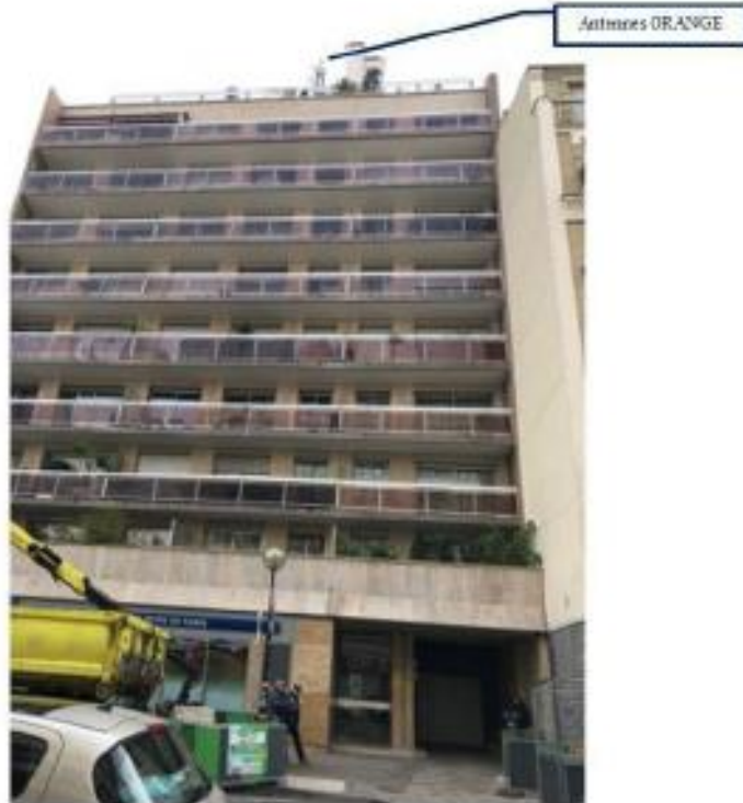
Prise de vue n°1 : vue depuis l'entrée de 109 rue St Charles.
