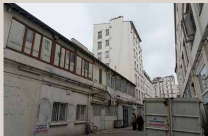
Vue actuelle des ateliers à droite de la cour.
