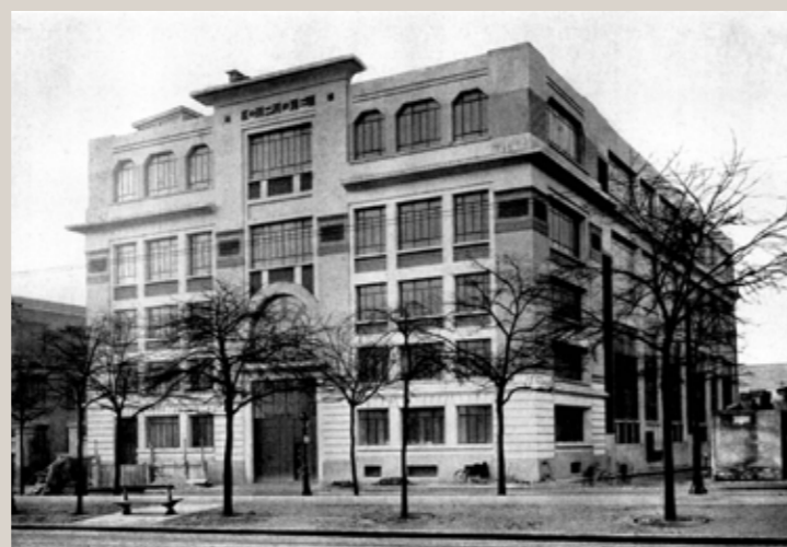
Vue actuelle de la façade boulevard de Charonne en 1930 (Archives EDF).
