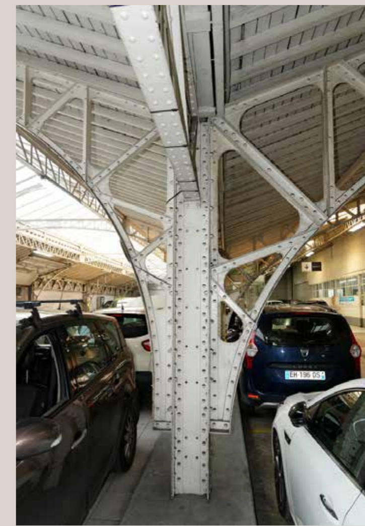
Vue actuelle de poteaux et de la charpente d'une halle métallique.
