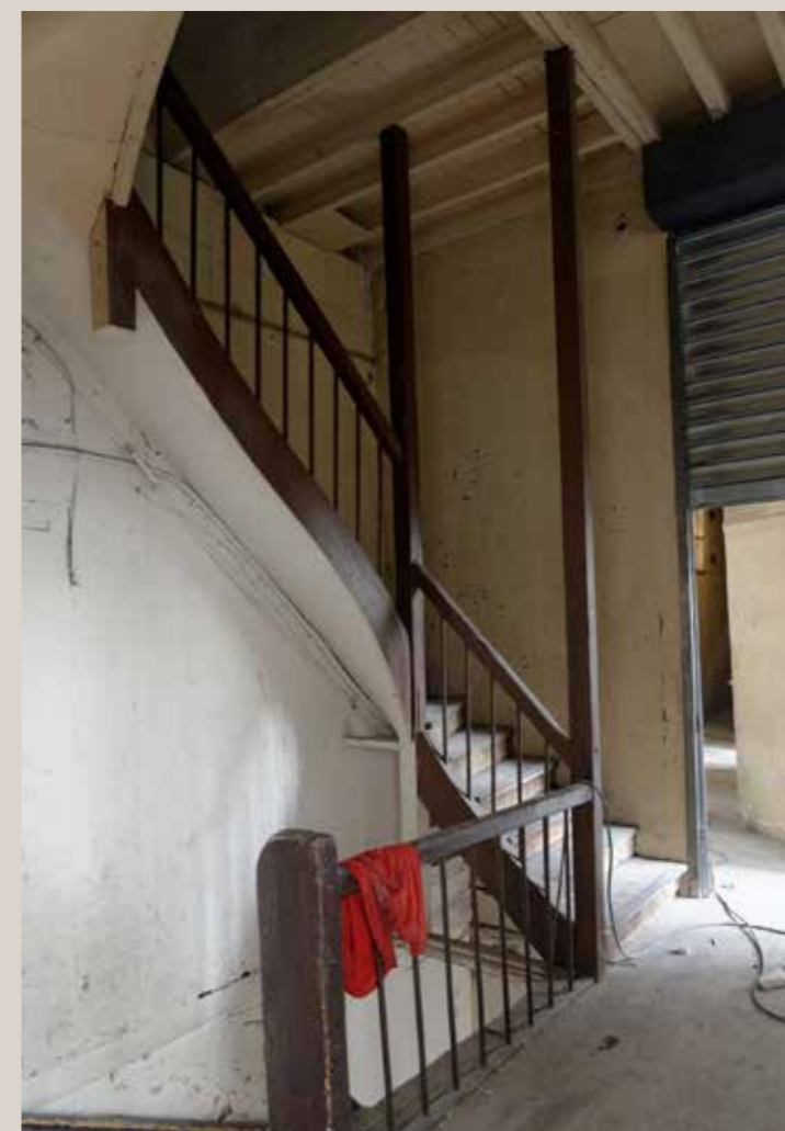
Vue de l'escalier à deux noyaux de bois et bareaudage en fer circulaire (ateliers à gauche de la cour).
