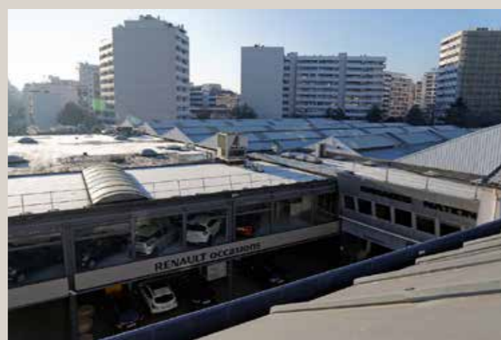
Vue actuelle des bâtiments concernés par la demande.
