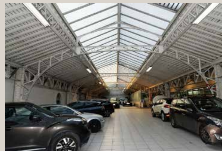
Vue actuelle de la verrière et d'une halle métallique.
