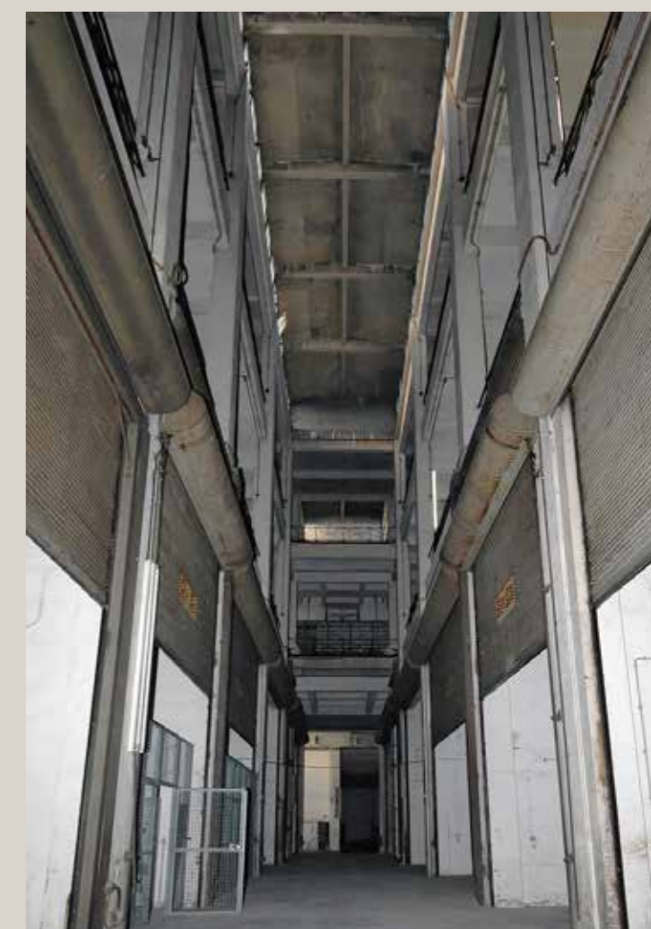
Vue actuelle de la « nef » centrale depuis le rez-de-chaussée.
