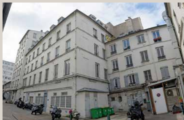
Vue des deux bâtiments d'habitation en ailes à droite après l'entrée (1842), destinés à être démolis.
