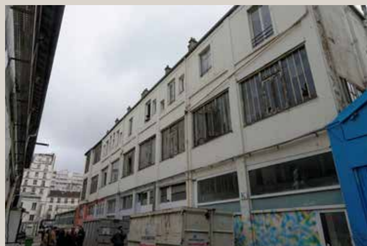
Vue actuelle des ateliers à gauche de la cour.
