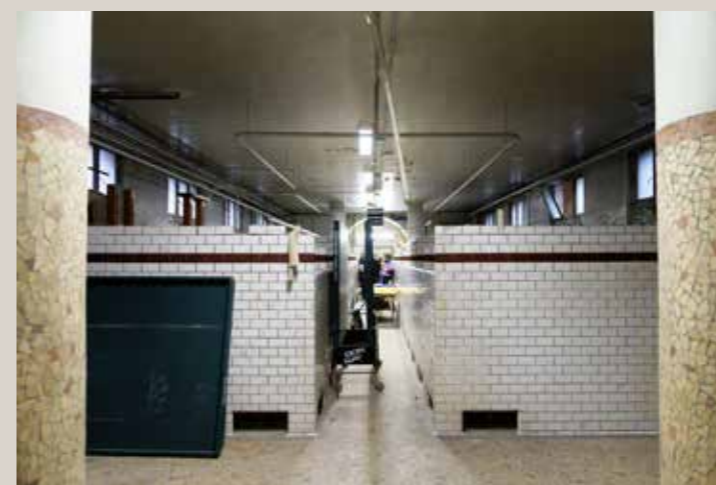
Vue actuelle de la salle des bains-douches.
