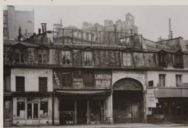
Vue de la partie du front bâti sur la rue La Fayette qui a été démolie en 1964 (© GRAHAL).
