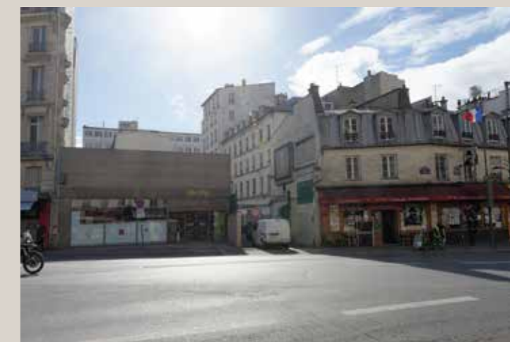
Vue des bâtiments de part et d'autre de la parcelle, avant l'étalement de la maison de droite.
