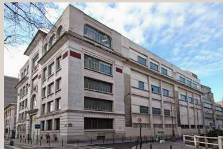
Vue actuelle du bâtiment depuis l'angle des deux voies.
