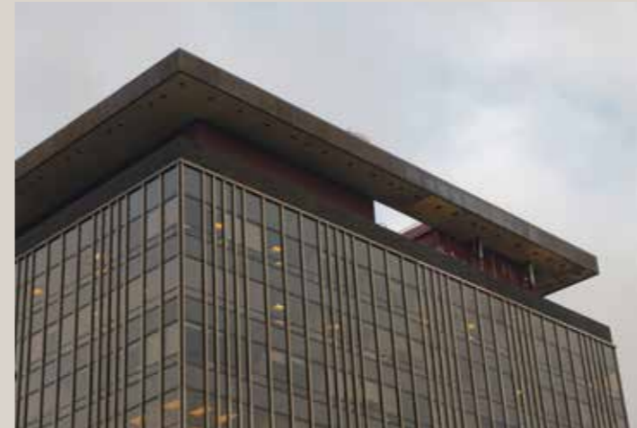
Détail du couronnement abritant les équipements techniques.
