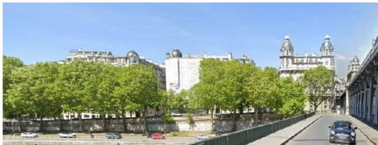
Etat projeté (Antennes non visibles depuis la voie publique)
