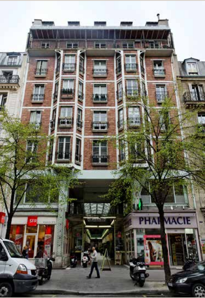
Vue actuelle de la façade sur l'avenue.
