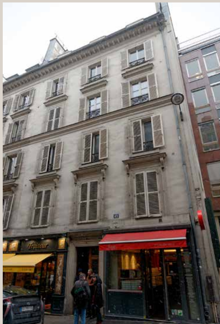
Vue actuelle de la façade sur rue.
