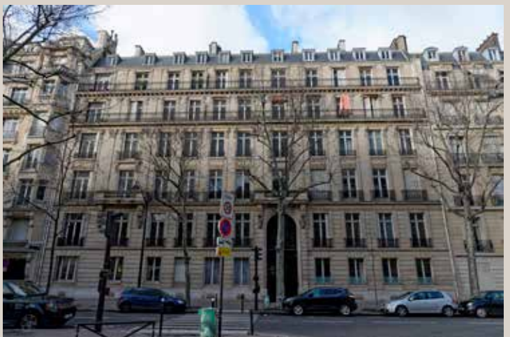
Vue actuelle de la façade sur l'avenue.
