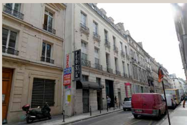
Vue actuelle de la façade sur rue.
