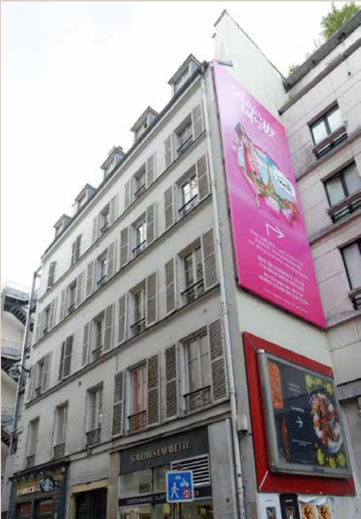
Vue actuelle de la façade sur rue.
