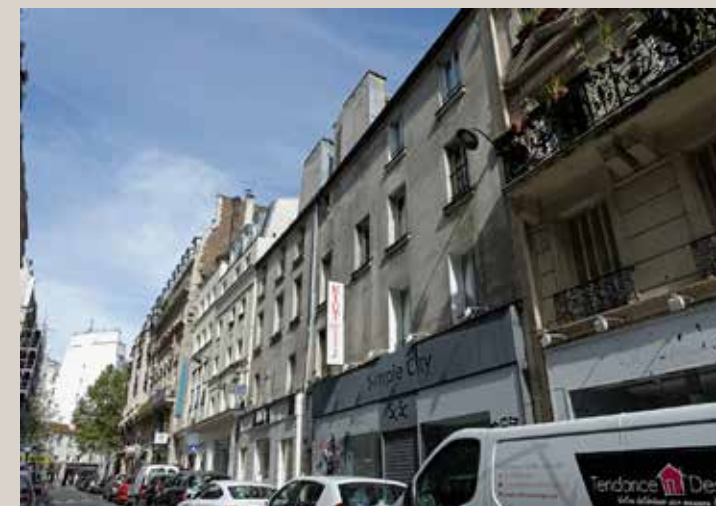
Vue actuelle de la façade sur rue.
