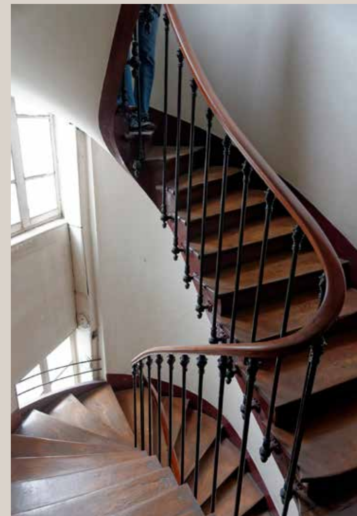
Vue actuelle de l'escalier d'origine.
