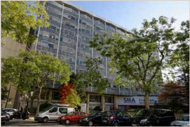
Vue actuelle du bâtiment depuis l'avenue Émile-Zola.
