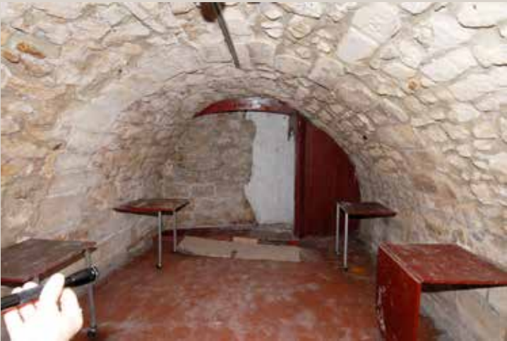
Vue des voûtes du sous-sol.
