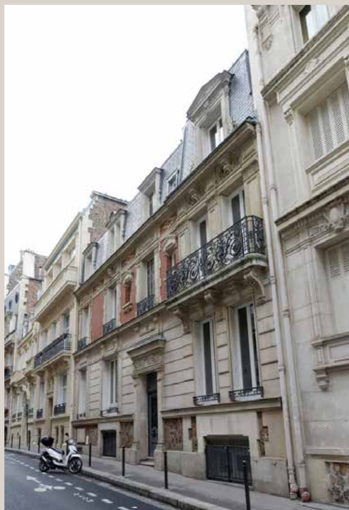
Vue actuelle de la façade sur rue.
