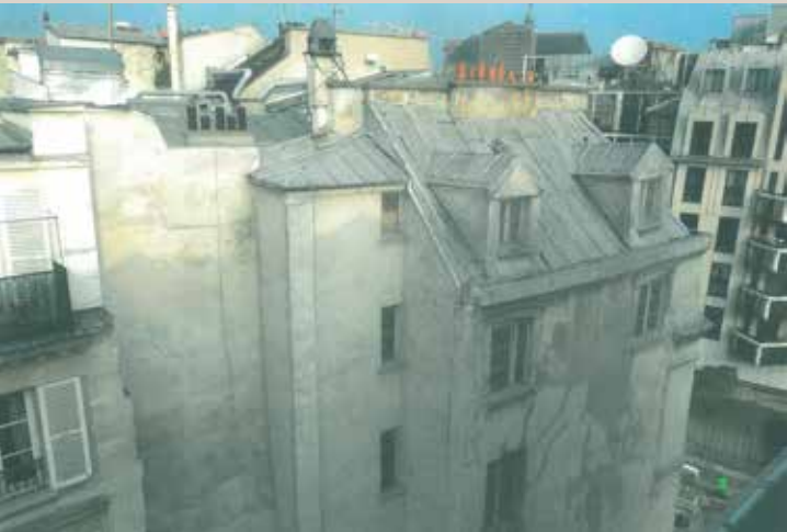
Vue de la toiture (© SAS FH Architecture).
