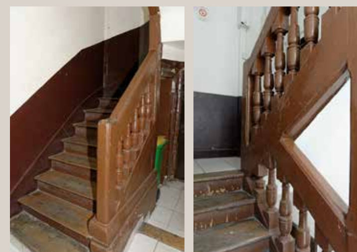
Vues actuelles de l'escalier d'origine.
