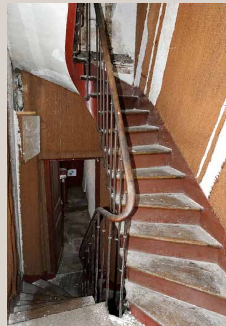
Vue actuelle de l'escalier principal.
