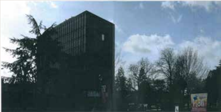
Vue récente du bâtiment depuis le jardin d'acclimatation (© Gehry & partners et Agence Search).
