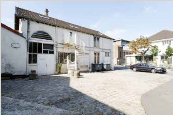
Vue des vacheries, laiteries, dont le permis de démolir est déposé (Charles-François Viel, 1807-1821).
