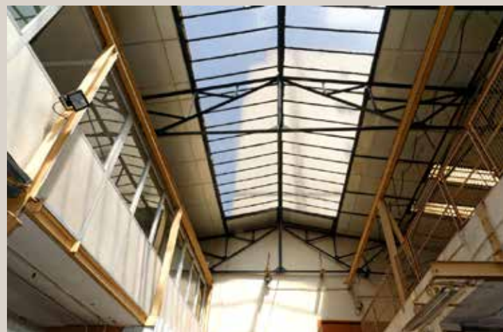
Vue actuelle de l'espace situé derrière le bâtiment sur rue.
