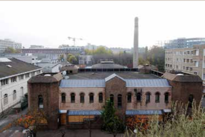
Vue du bâtiment des services techniques (Fourquier et Filhol, 1985).
