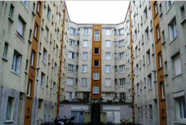
Vue actuelle depuis la cour (© ICF La Sablière).
