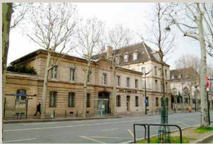
Perspective actuelle de l’avenue. Au premier plan, les constructions de 1880. Au fond, la cour puis la chapelle du XVII e siècle.
