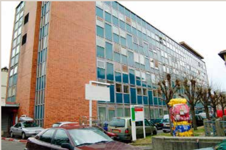
Vue de l'aile ajoutée entre les ailes de l'orphelinat (Larrousse et Desprez, 1963-1971).
