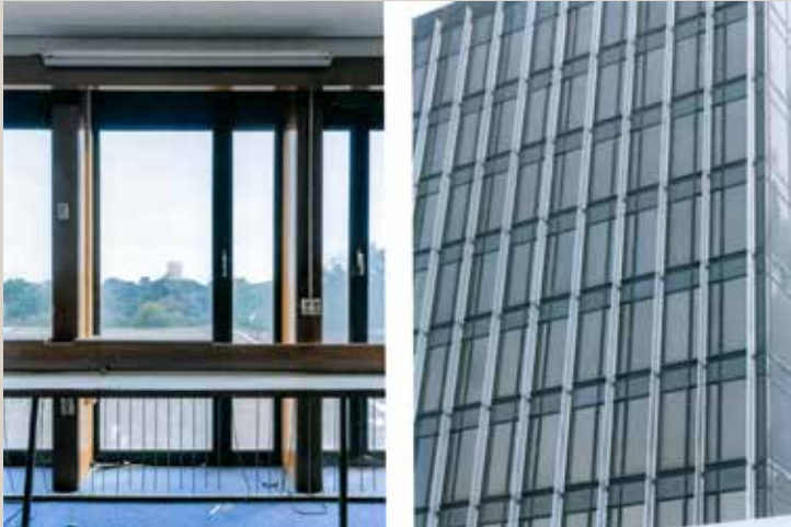
Vue d'une baie depuis l'intérieur et détail des montants verticaux formant brise-soleil (© Gehry & partners et Agence Search).
