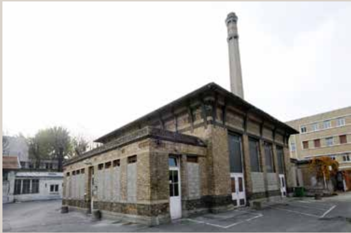
Vue de la chaufferie (Félix Debat, 1834).
