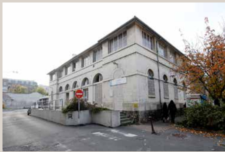
Vue actuelle de la buanderie désaffectée (1845).
