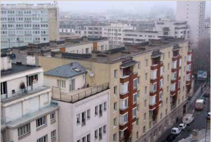
Vue actuelle depuis les toits (vers le nord-est) (© ICF La Sablière).
