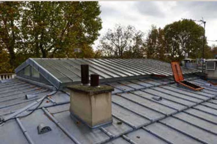
Vue de la toiture existante.
