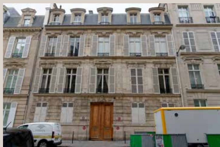
Vue actuelle de la façade sur rue.
