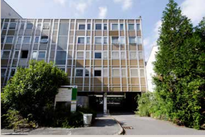
Vue du revers du bâtiment implanté 53, rue Boissonade (Larrousse et Desprez, fin des années 1960).
