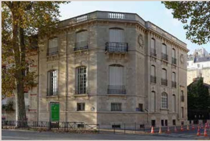
Vue actuelle du bâtiment à l’angle de l’avenue de New-York et de la rue de la Manutention.
