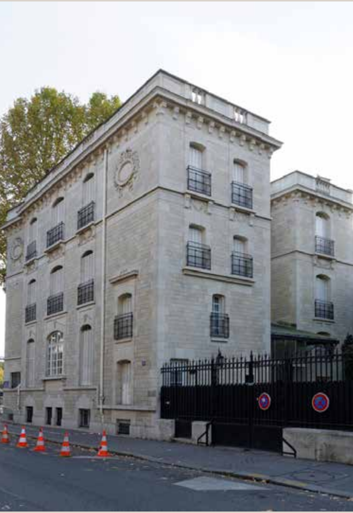
Vue actuelle de la façade, côté rue de la Manutention.
