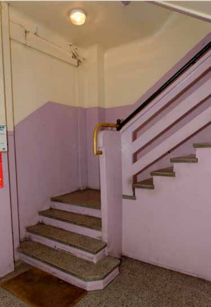
Vue actuelle d’un départ d’escalier.
