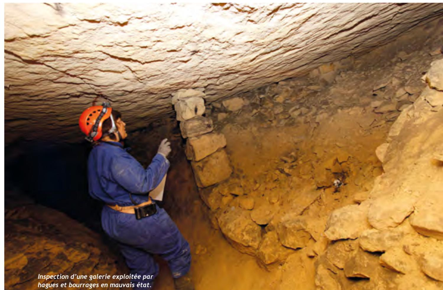
Inspection d'une galerie exploitée par haques et bourrages en mauvais état.
