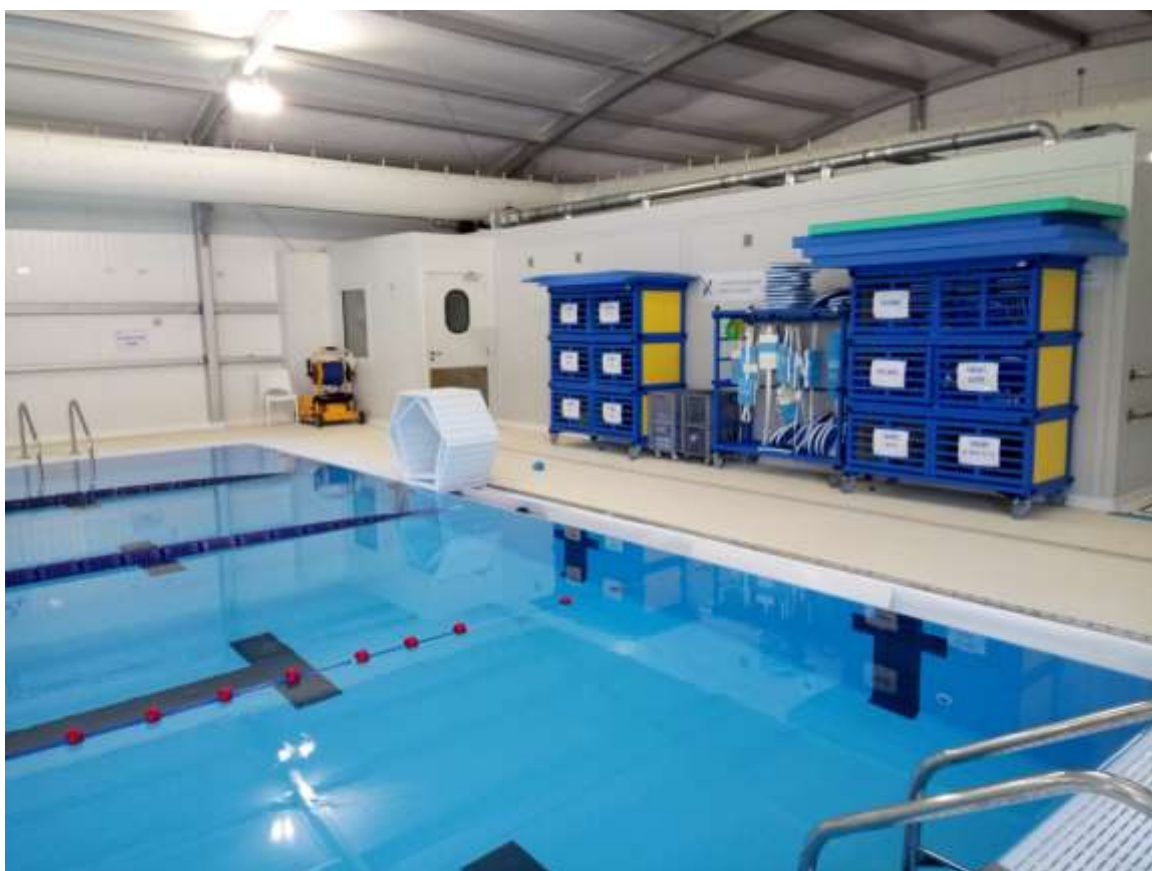
8. Vue de la halle bassin avec le caillebotis de la goulotte tampon partiellement replié.
