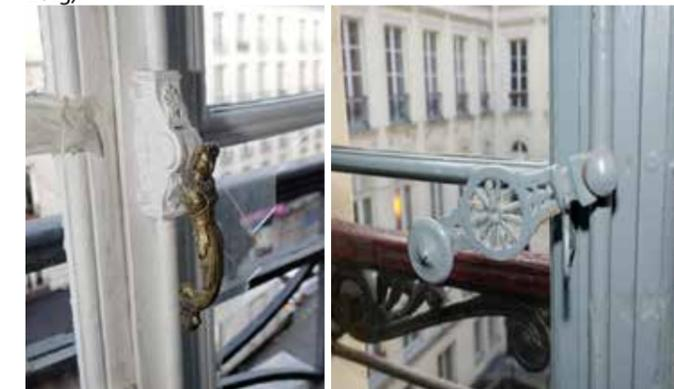
Ci-dessus : détails de crémones, à gauche côté rue et à droite, sur un palier côté cité.
