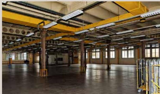
Vue actuelle du plafond du 2<sup>e</sup> étage avec la nouvelle charpente.
