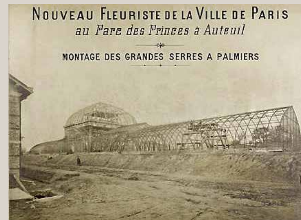
Vue du palmarium en construction, 1898 (Albert Chevojon, photographe, © BHDV / Roger-Viollet).
