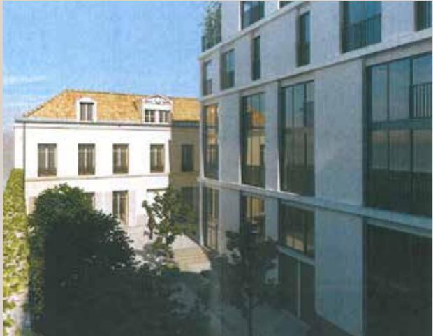
Vue projetée de la maison des années 1840 conservée et restaurée au fond de la parcelle (© Acoupe! architecture).
