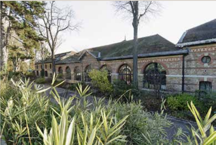
Vue actuelle de la façade nord du bâtiment de l'orangerie.
