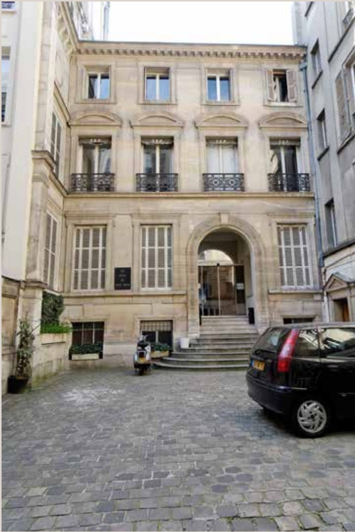
Vue actuelle de la façade sur cour.
