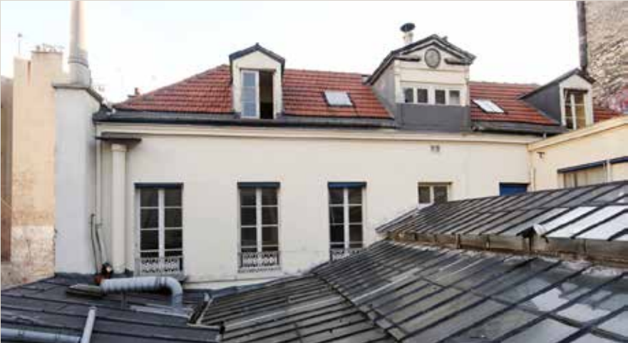
Vue actuelle des parties hautes de la maison du fond de la parcelle.
