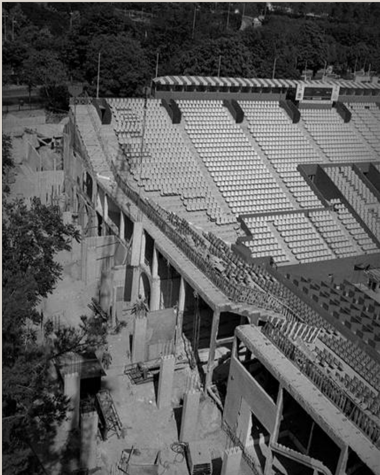
Travaux de réfection du court central en août 1987 (© Carlos Gayoso / Roger-Viollet).
