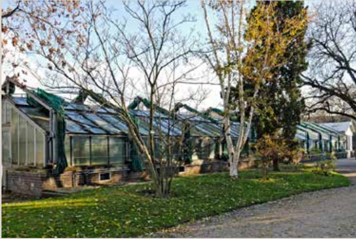
Serres à multiplications actuelles, dont la démolition est demandée.
