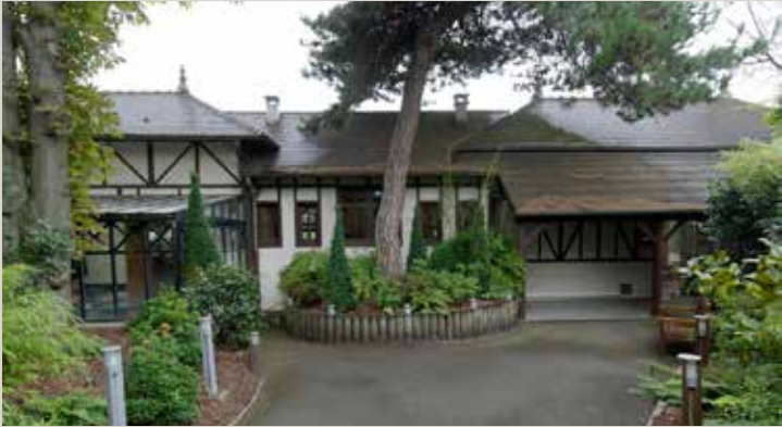
Vue du pavillon d'entrée du restaurant.
