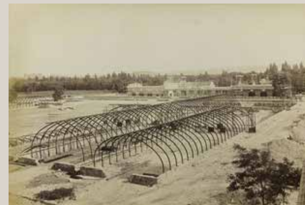
Vue des serres latérales en construction, 1896 (© Jean Eugène Durand. / BHDV / Roger-Viollet).
