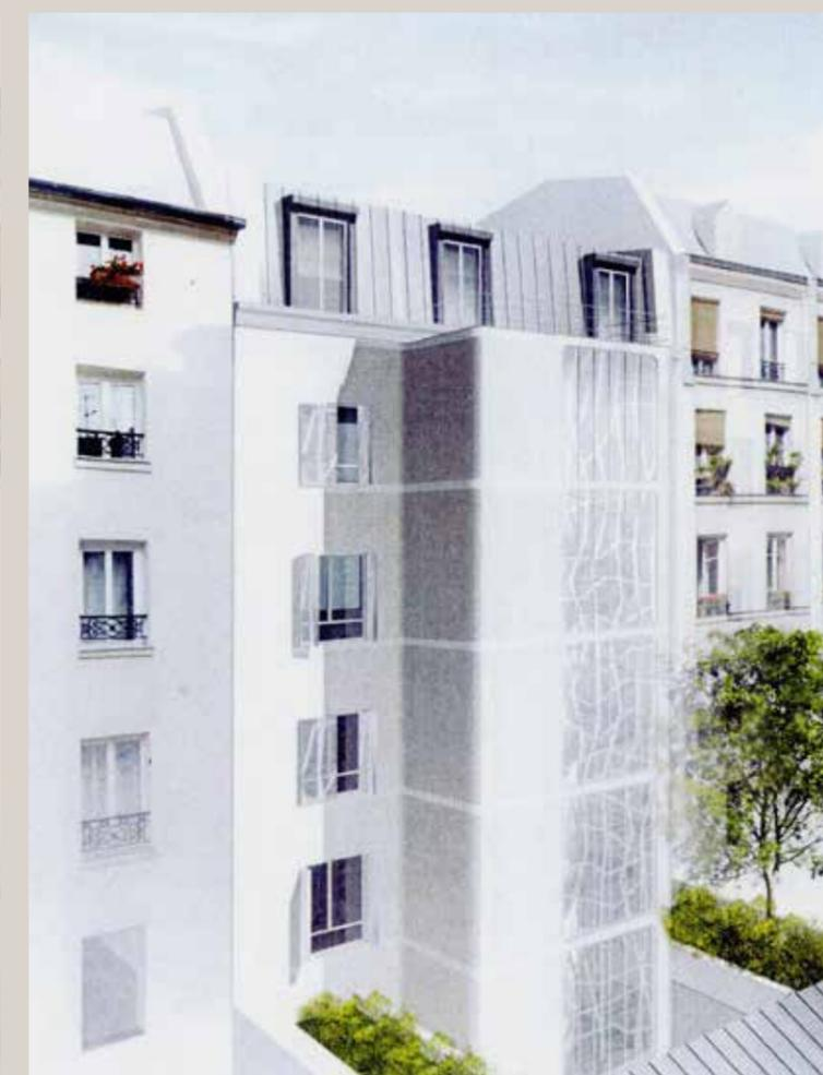
Vue projetée de la façade arrière, isolée par l'extérieur et avec une nouvelle cage d'escalier et d'ascenseur hors-oeuvre. Les baies seraient totalement transformées. (© Arteo architectures).
