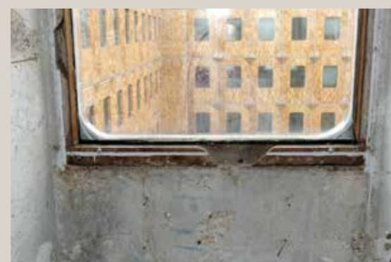
La mise en œuvre voit les vitres posées à joints vifs, plaquées par l'entremise d'une menuiserie sans ouvrant.
