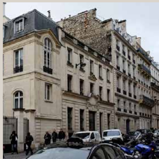
Vue actuelle de la façade sur la rue.
