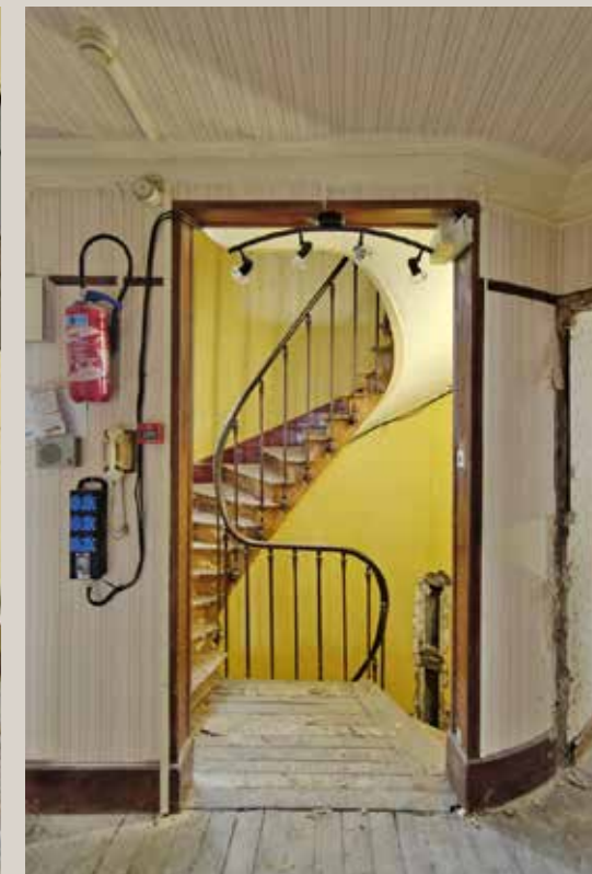
Vue actuelle de l'escalier, qui serait conservé dans les étages.
