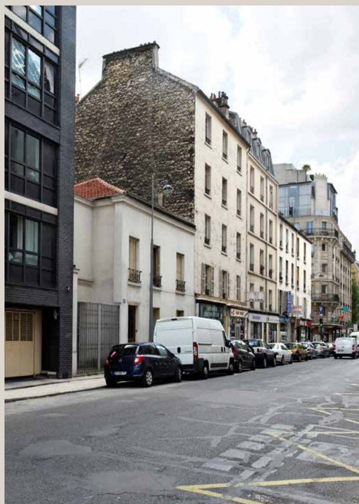
Vue actuelle de l'ensemble immobilier sur la rue Lecourbe.
