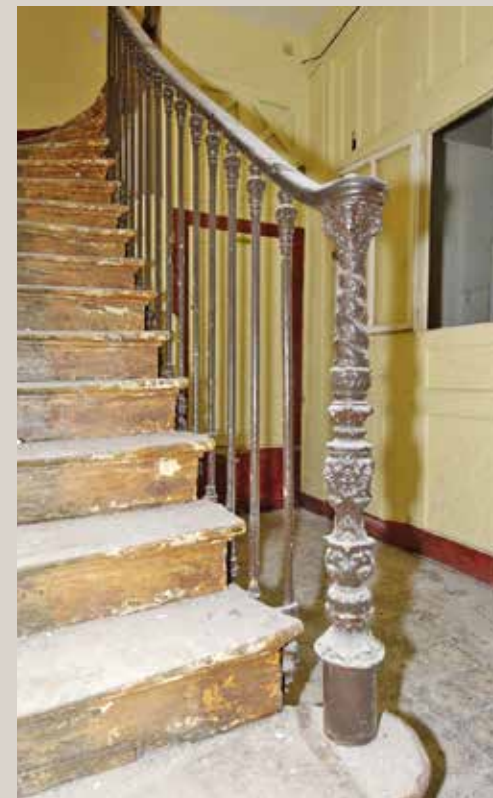
Vue actuelle du départ de l'escalier, qui serait démolir.
