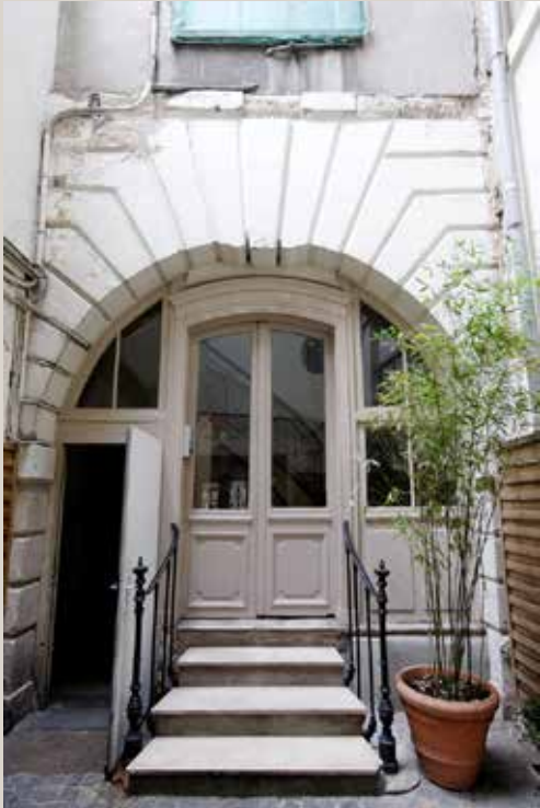
Arc à bossages datant vraisemblablement de la première campagne de construction de 1607, situé sur la façade du bâtiment du fond de cour.
