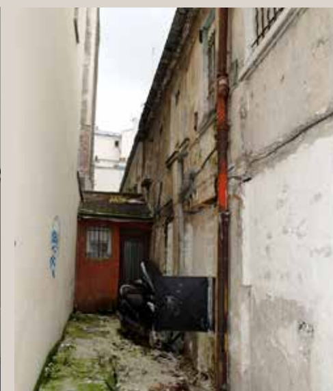
Vue des espaces arrière entre le revers des maisons et les héberges mitoyennes.
