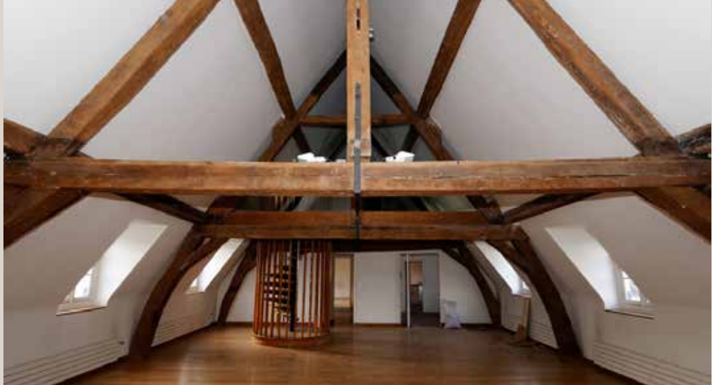
Vue actuelle des combles du corps principal de l'hôtel de Selve dont l'aménagement conservera les éléments de la charpente encore en place.
