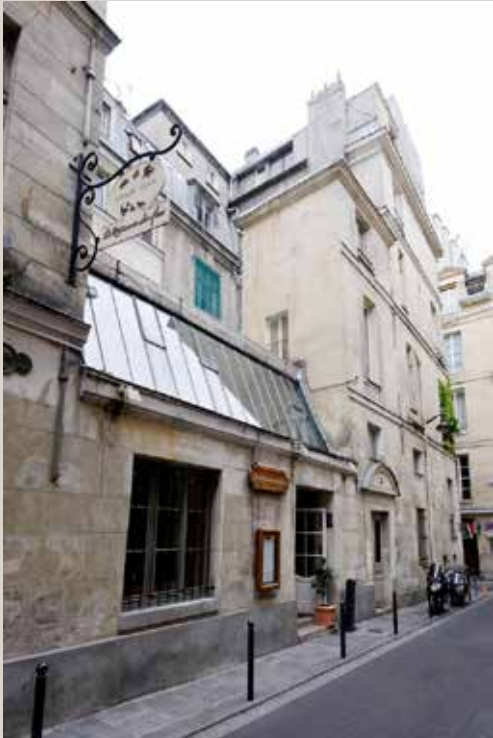
Vue de l'ancien mur de clôture rue Christine, modifié en 1865 avec le comblement de la cour pour l'installation d'ateliers.
