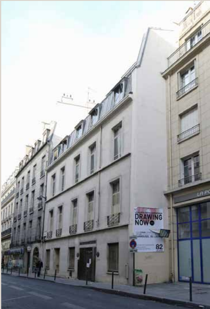
Vue actuelle de la façade.
