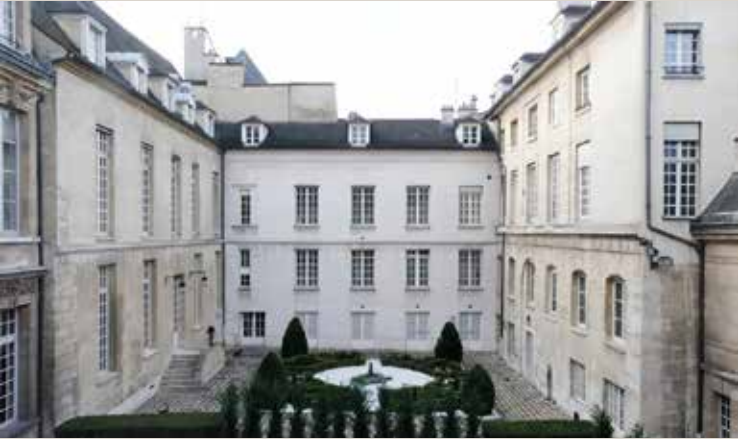
Les deux cours actuellement réunies, vues depuis hôtel de Selve (en haut), et depuis hôtel de Miramion (en bas).
