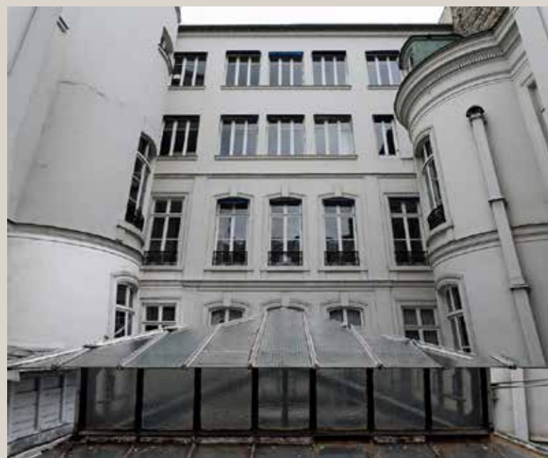
Vue actuelle de la façade au fond de la première cour
