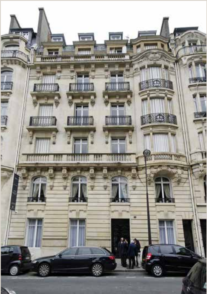
Vue actuelle de la façade.
