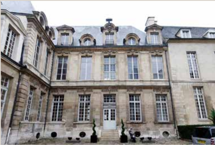
Vue actuelle de la façade sur cour du corps de bâtiment principal de l'hôtel de Miramion.
