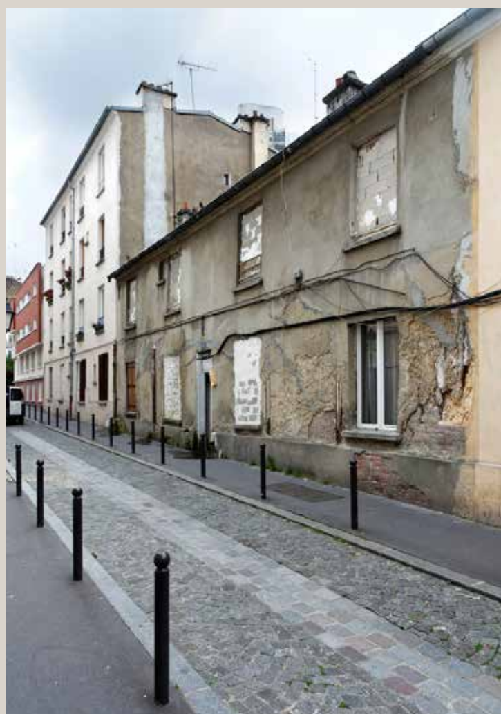
Vue actuelle du n° 6, passage Desgrais.
