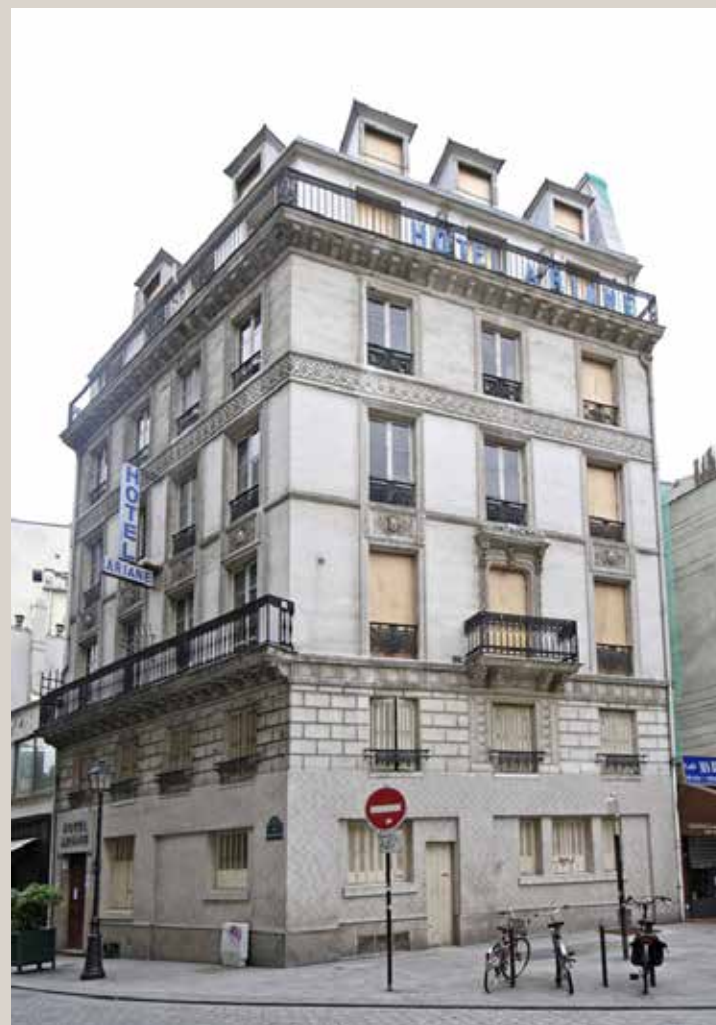
Vue actuelle de l'immeuble à l'endroit où la rue René Boulanger s'élargit, lui donnant ainsi une grande visibilité.
