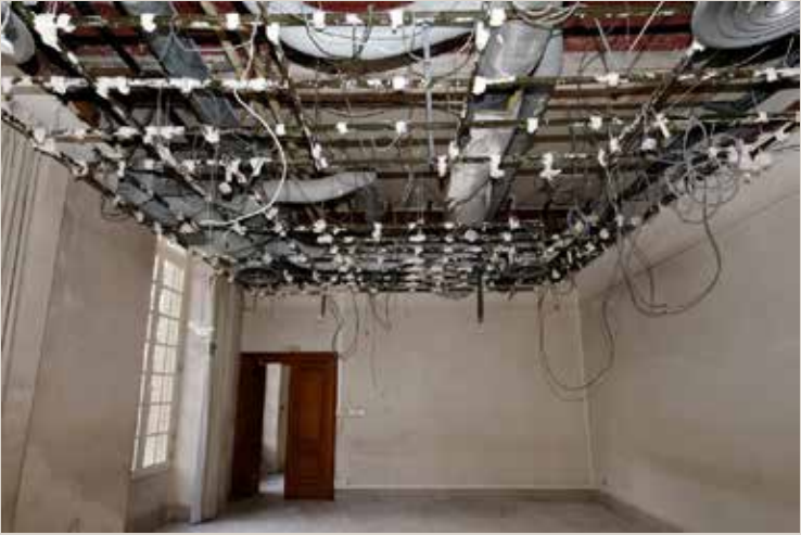
Vue actuelle d'une des salles du rez-de-chaussée du corps de logis principal de l'hôtel de Selve.
