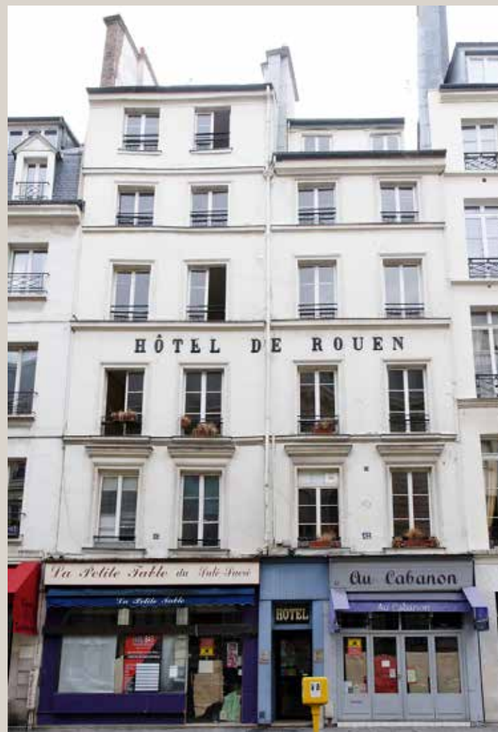
Vue actuelle de la façade.
