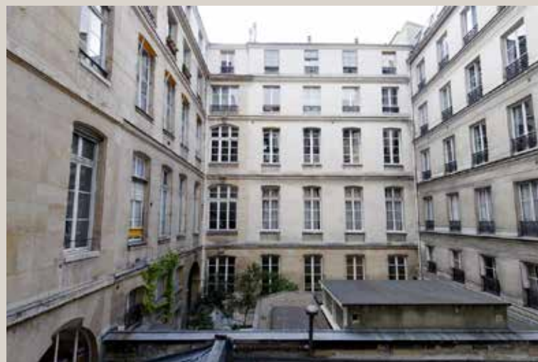
Vue de la cour du n°31.
