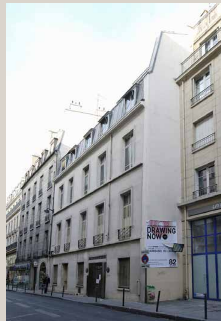
Vue actuelle de la façade.
