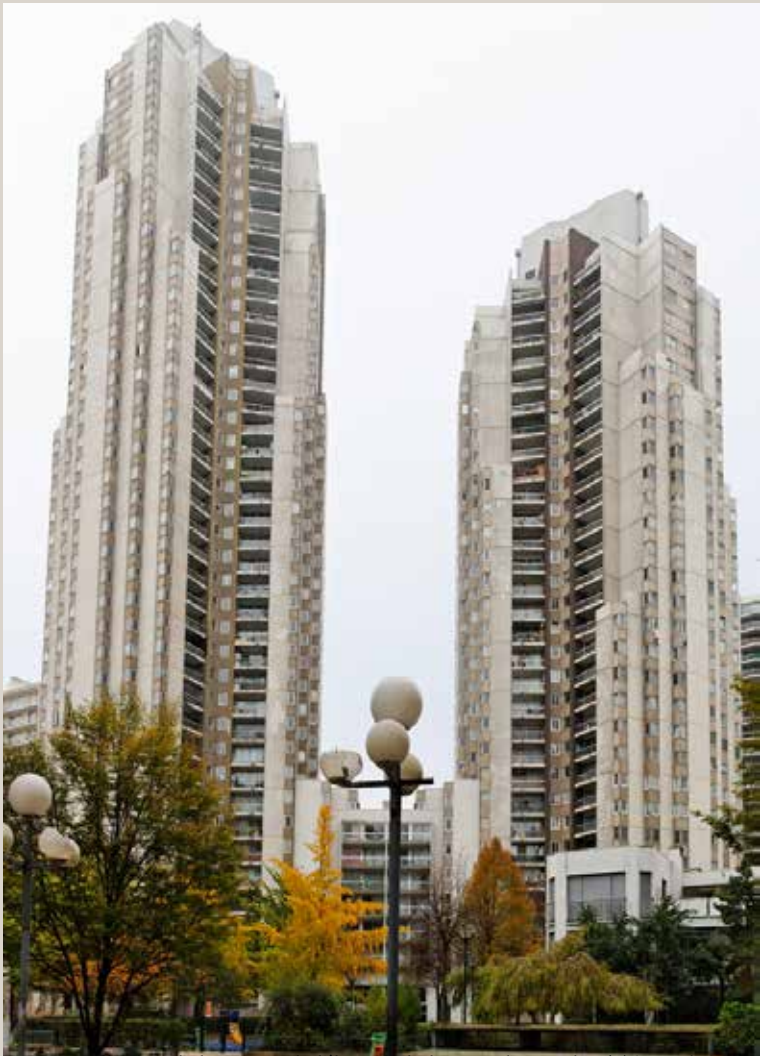
Vue actuelle depuis le centre de l'îlot. Seule la tour de gauche (T1) serait isolée par l'extérieur.
