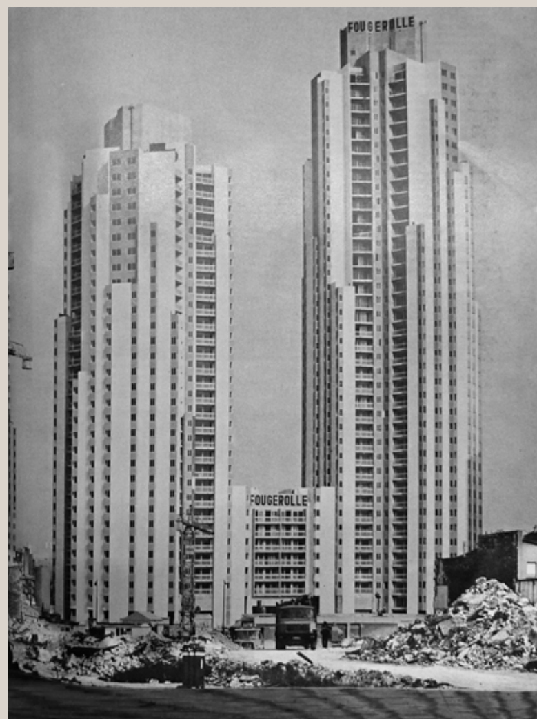
Vue des tours en voie d'achèvement en 1974 ( Bâtir , n°29, mars 1974).
