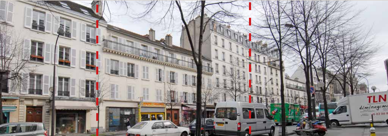
Vue actuelle de la rue de la Chapelle vers le sud. Le n°40, à trois étages, serait conservé et réhabilité. Son voisin de droite (n°38) est hors projet. Les démolitions portent sur les constructions sur cour.
