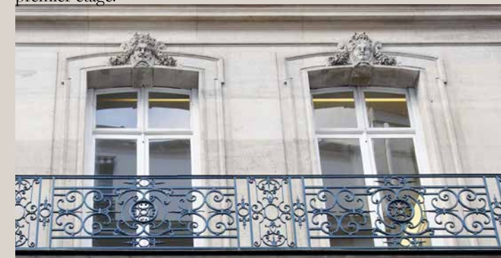
Détail des fenêtres sur rue du n°33, rue Danielle Casanova, au deuxième étage.
