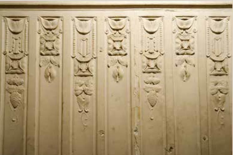
Détail d'un décor de plâtre au mur du hall d'accès au logement.
