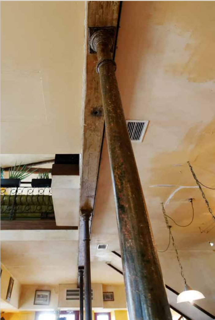
Vue actuelle des colonnettes de fonte de la salle du rez-de-chaussée.
