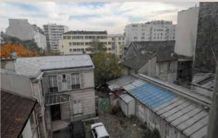
Ailes en retour du n°40 dont la démolition est demandée ainsi que celle du pavillon du XIX e siècle entre cour et jardin.
