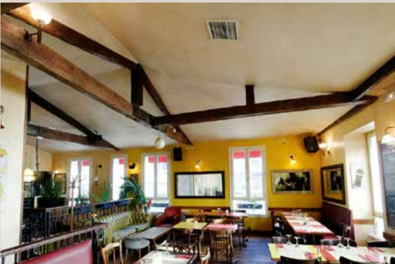
Vues actuelles de la salle du premier étage.
