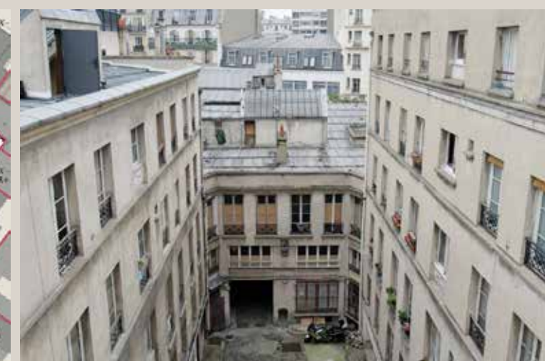
Vue actuelle de la cour et du revers du bâtiment sur rue. La surélévation des années 1860 est visible à gauche de la verrière de l'escalier.
