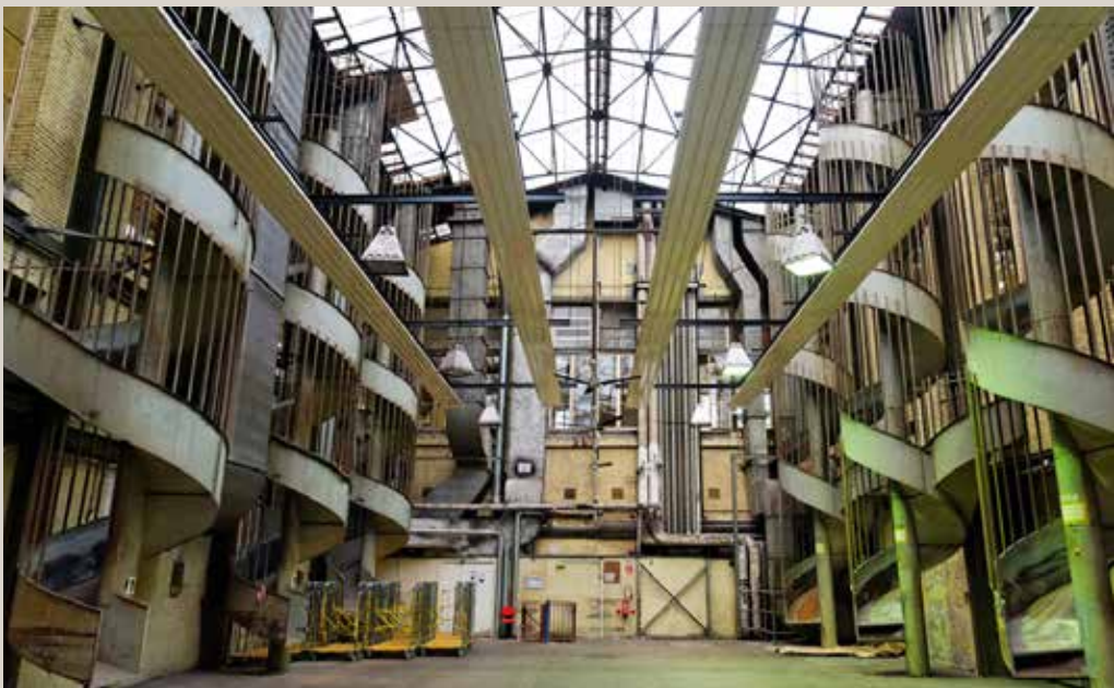
Vue actuelle de la cour couverte avec les toboggans résultant de la mécanisation de la manutention mise en place après-guerre.
