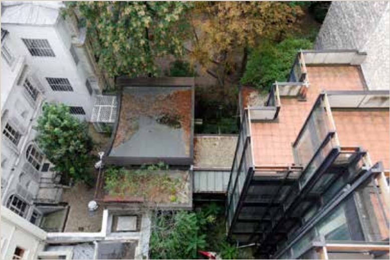
L’aile en retour du bâtiment rue épouse le gabarit réglementaire par un échagement successif de ses niveaux.
