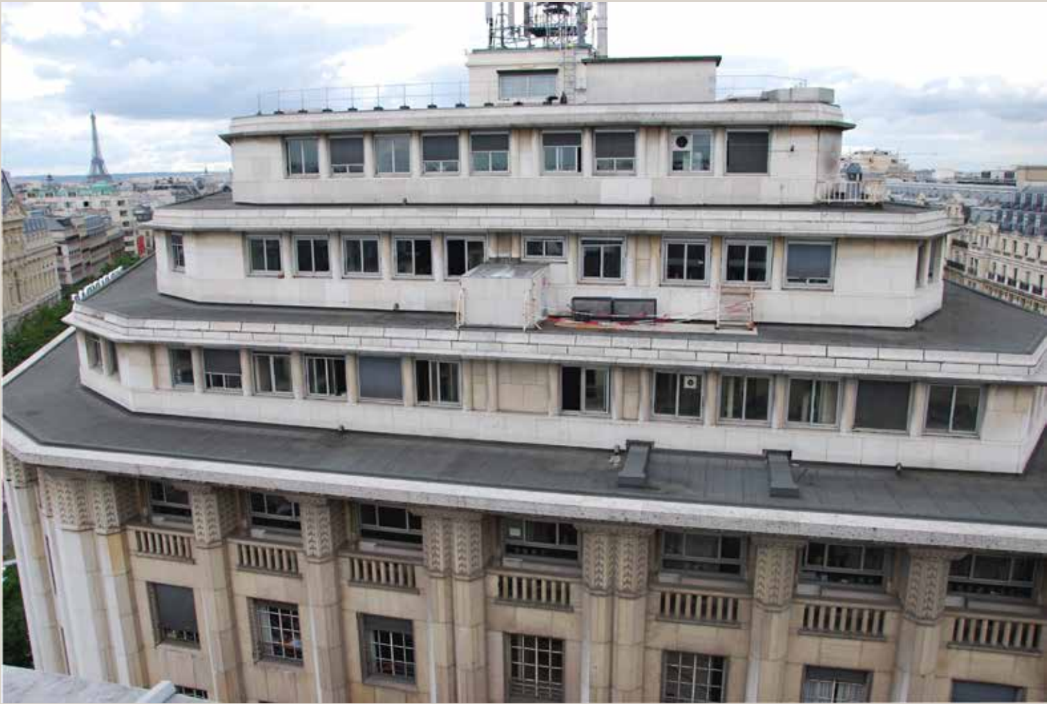
Vue actuelle de la façade côté rue Le Peletier. Le projet prévoit la dépose des allèges aux trois derniers niveaux (cliché Groupe BNP).
