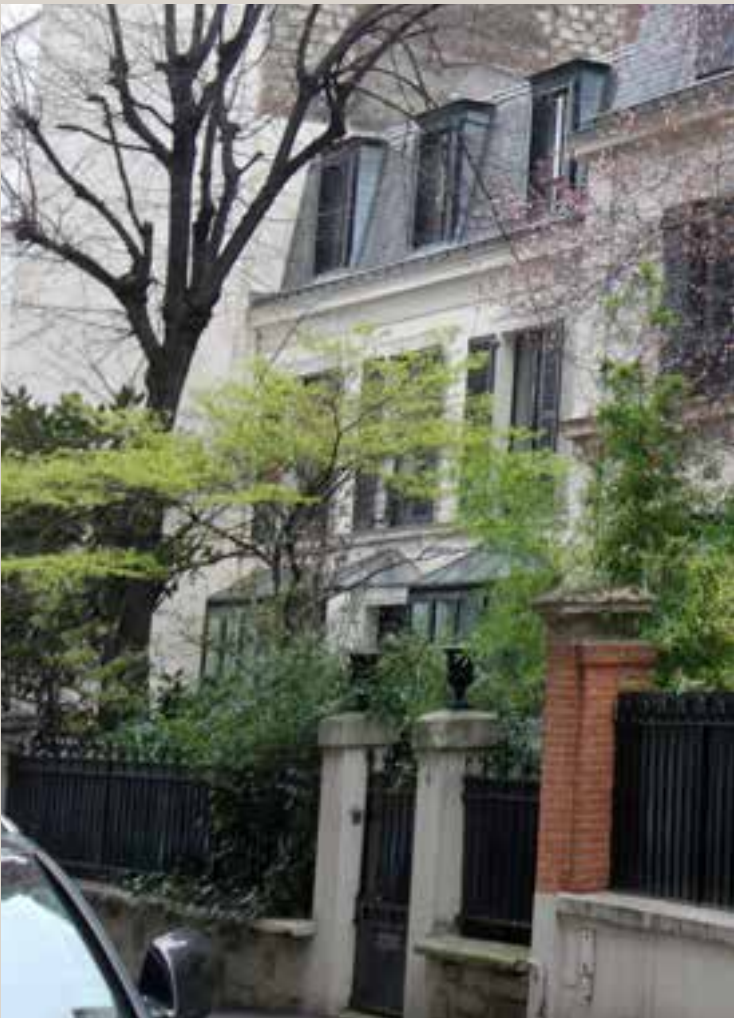
Vue actuelle de la façade sur la rue.
