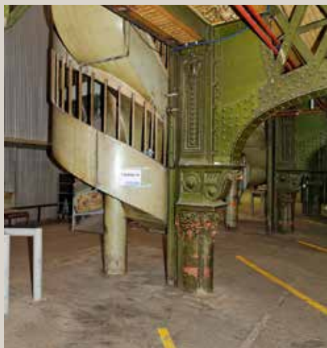
Détail de l'entresol sur rez-de-chaussée.
