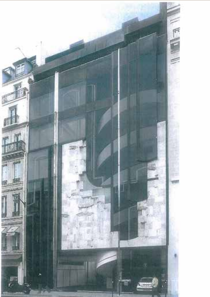
Vues actuelle et projetée de la façade sur l'avenue Matignon (© Wilmotte & associés). Les vitrages seraient doublés par l'intérieur dans un souci de meilleure performance énergétique. Le nouvel escalier monumental serait visible en second jour des parties vitrées.
