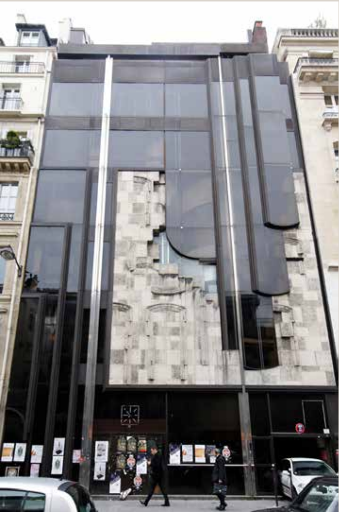
Vue actuelle de la façade sur l’avenue Matignon.
