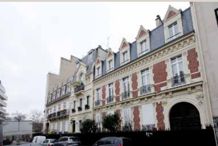
De gauche à droite : vue actuelle des façades des n° 20, 18 et 16.
