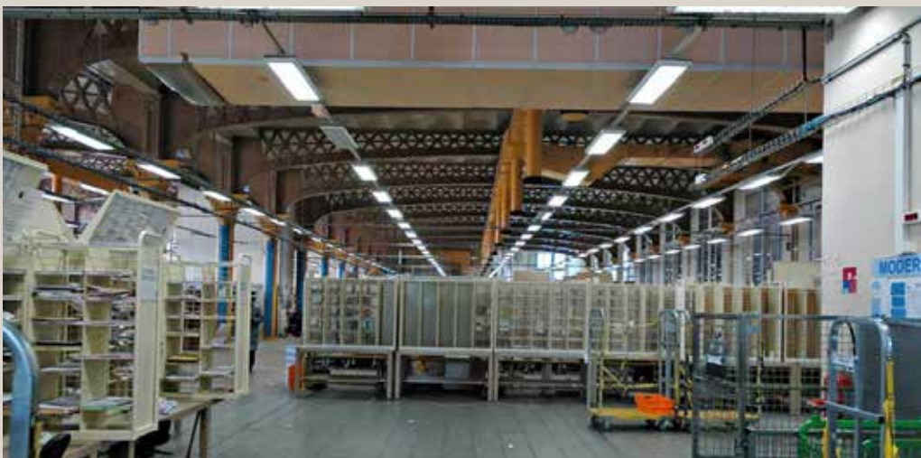
Vue actuelle du grand hall au 1 er étage.
