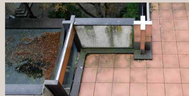
Émergence sur la terrasse du troisième niveau d'une des piles cruciformes dont l'implantation répond à une logique de tracé régulateur.
