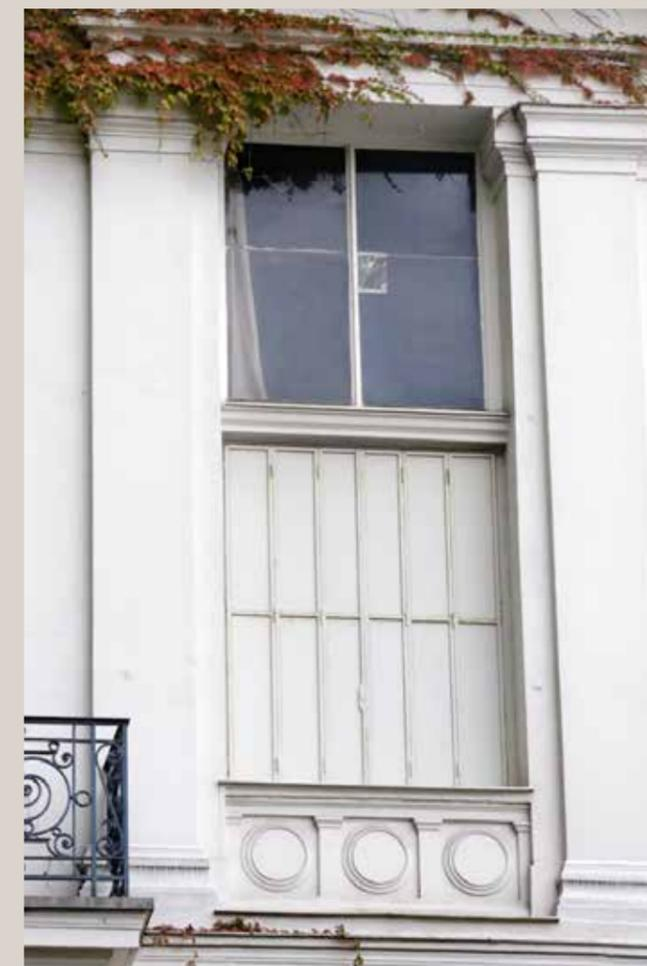
Détail d'une baie latérale de l'atelier. La jonction entre les vitres d'un même vantail est faite d'une fine baguette de cuivre.
