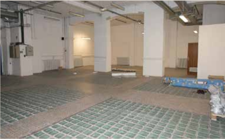
Vue actuelle de la cour couverte montrant les dalles de verre d'origine permettant d'éclairer le sous-sol.
