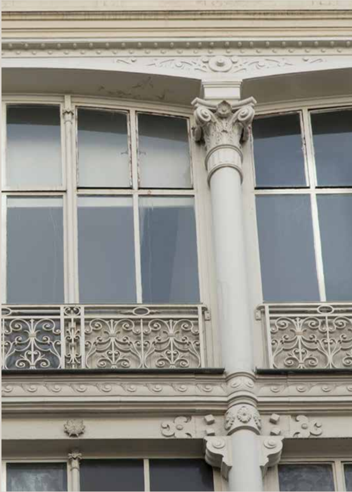
Détail de la façade sur la rue du Plâtre.
