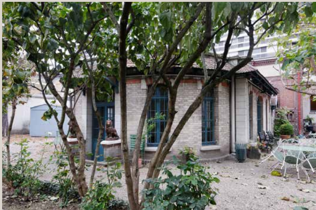
Extension de l'actuelle bibliothèque formée par la couverture de l'ancien bassin.
