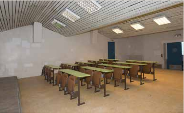
Vue actuelle de la salle de projection occupant l'espace de la cour au 1er étage.
