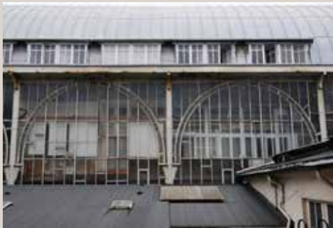
Façade latérale du bâtiment du fond : une seconde paroi vitrée a redoublé la grande verrière.
