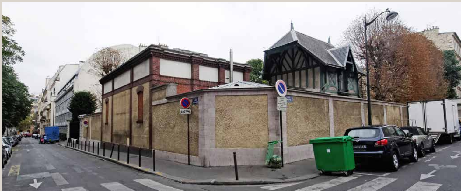
Vue actuelle de l'angle des rues Saint-Didier et du Mesnil. À gauche, l'actuelle bibliothèque (ancienne loge), à droite, les anciennes écuries.
