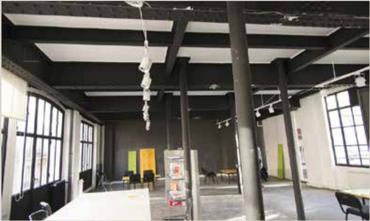
Vue générale de l'étage sous combles montrant la structure de poteaux en fonte.
