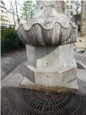
Fontaine du square Padeloup problème dans l'écoulement pas de tuyau raccord, l'eau tombe directement sur le sol
