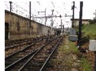
Zones extérieures Surfaces : 2,8 ha Travaux : dévoieement réseaux, déséquipement et arase
