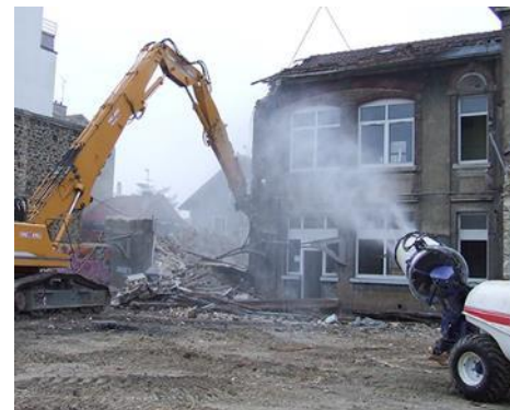
Système de brumisation d'une zone complète
