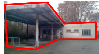
Bâtiment G Surfaces : 183 m 2 Travaux : désamiantage et démolition
