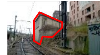
Bâtiment E Surfaces : 229 m 2 Travaux : désamiantage et démolition
