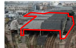
Bâtiment B/C Surfaces : 9800 m 2 Travaux : désamiantage et démolition
