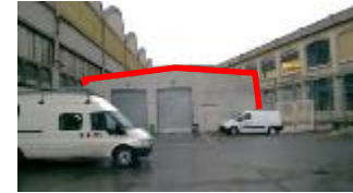
Bâtiment F Surfaces : 638 m 2 Travaux : désamiantage et démolition
