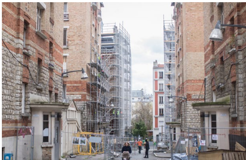
Réhabilitation des 610 logements de la résidence Fécamp-Édouard Robert-Tourneux
