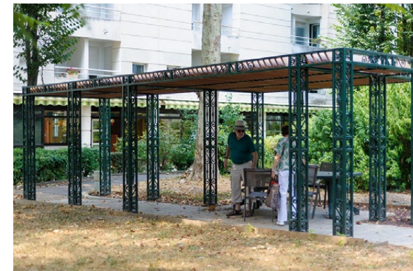
Ombrière de l'Ehpad Furtado Heine
