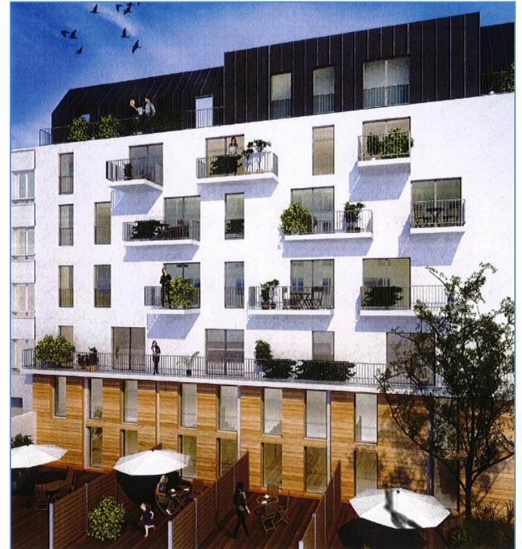
Insertion façade côté cour. Architecte J. ROUVE
