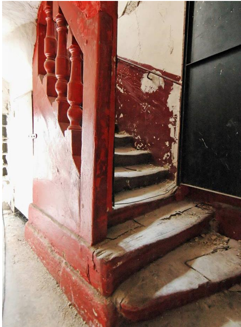
Ci-dessus : l'escalier d'origine de la maison qui sera conservé.
