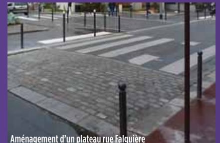
Aménagement d'un plateau rue Falguière
