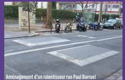
Aménagement d'un ralentisseur rue Paul Barruel
