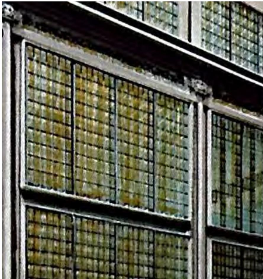
Ci-dessus : travée type de la façade d'origine, relevée en 1967 (à gauche) et projetée (à droite) ; détail d'un caisson garni de panneaux de verre dichroïque.
