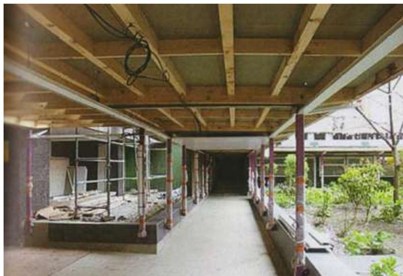
*Ci-dessous : à gauche, vue du chantier montrant la reconstruction des coursives, l'élargissement de la couverture, le choix singulier de la polychromie et la mise en place d'un garde-corps empêchant aux usagers de s'asseoir sur les murets.*
