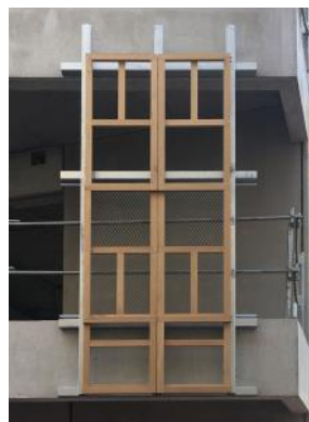
Test de la vêtture sur la façade
