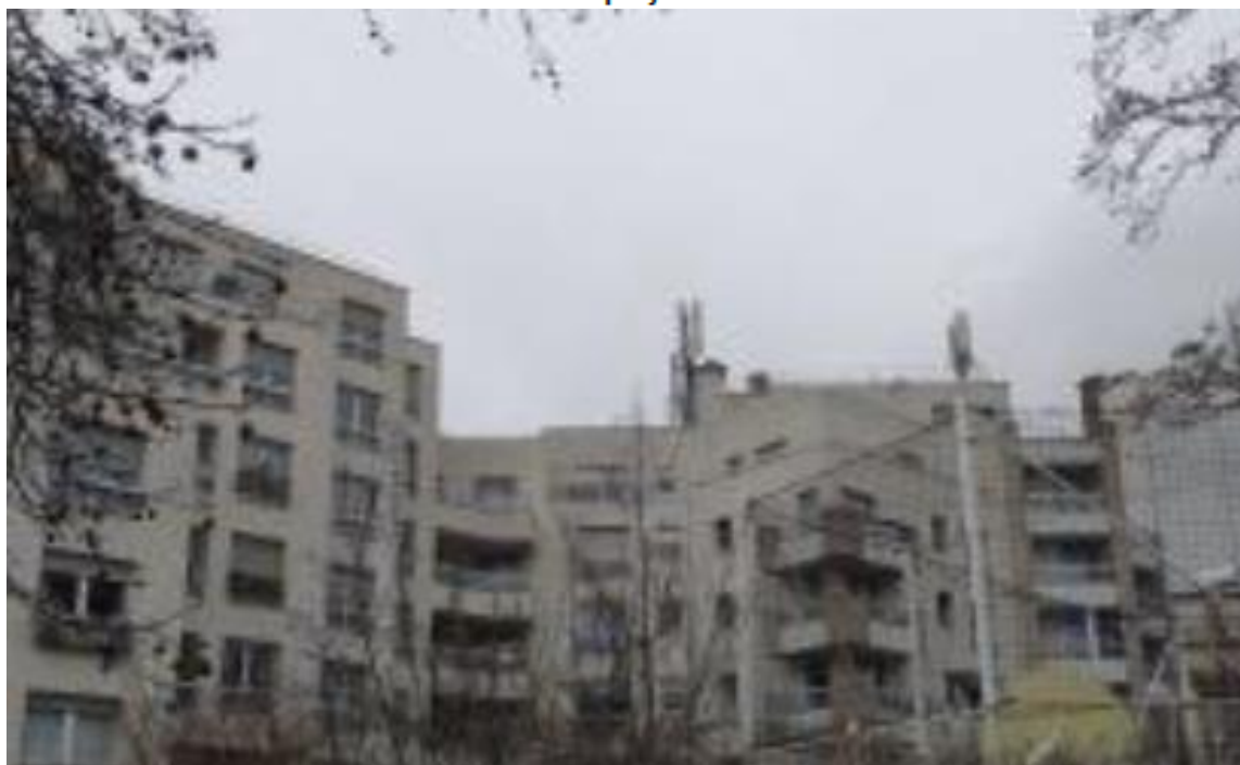
Pas de modification de l'aspect extérieur de l'installation.
