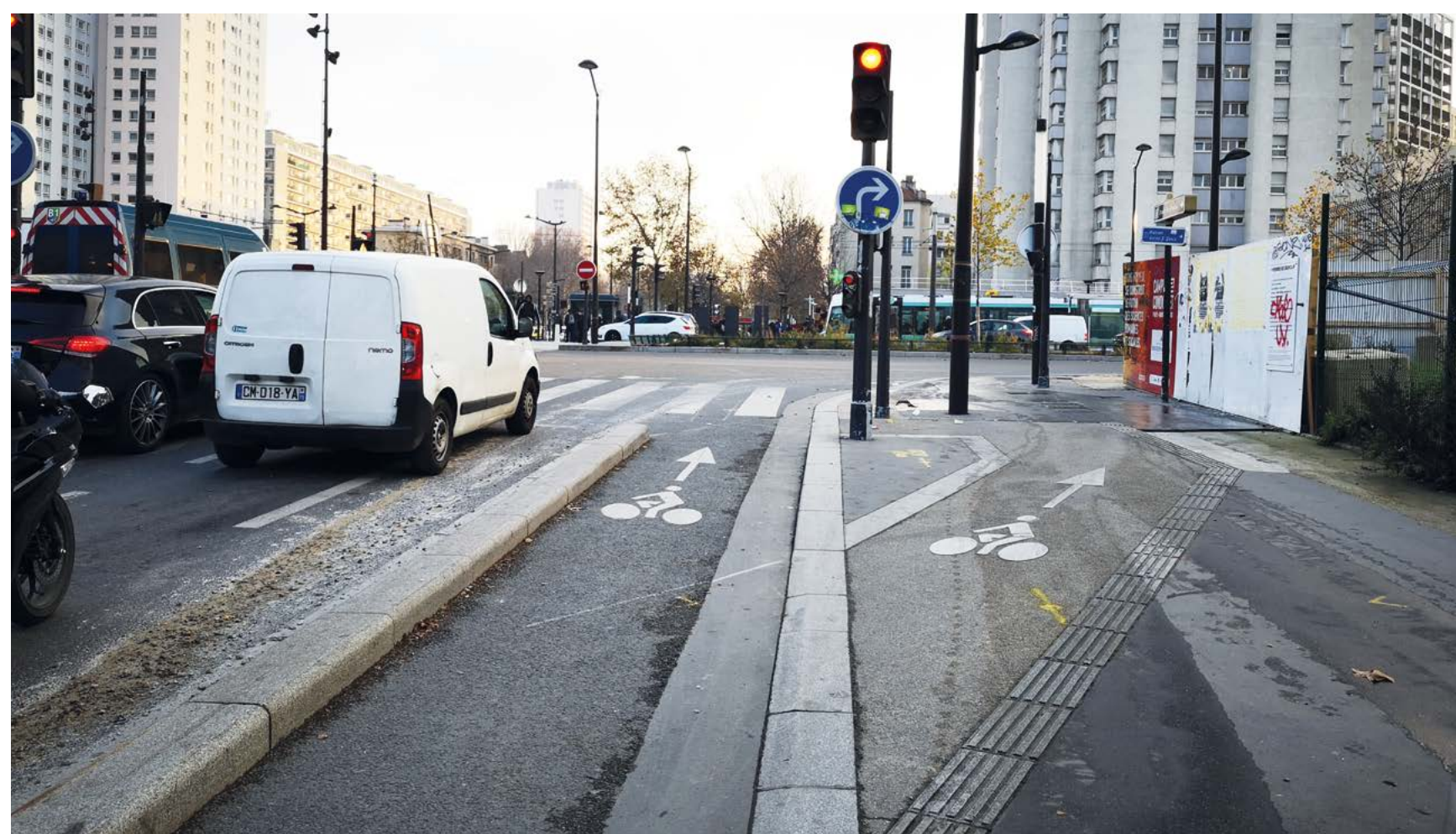
Une piste protégée par un séparateur granit
