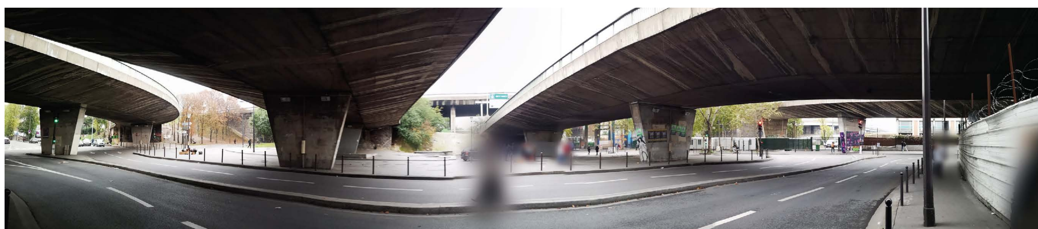
De grands espaces délaissés sous les ouvrages routiers à valoriser
