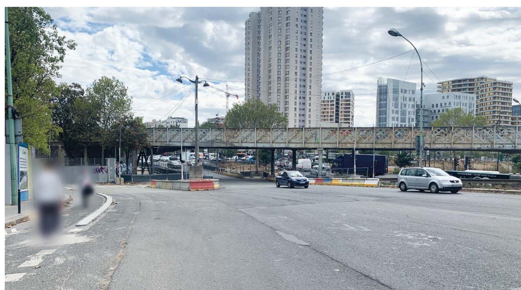
Une chaussée circulée très large et des trottoirs trop étroits
