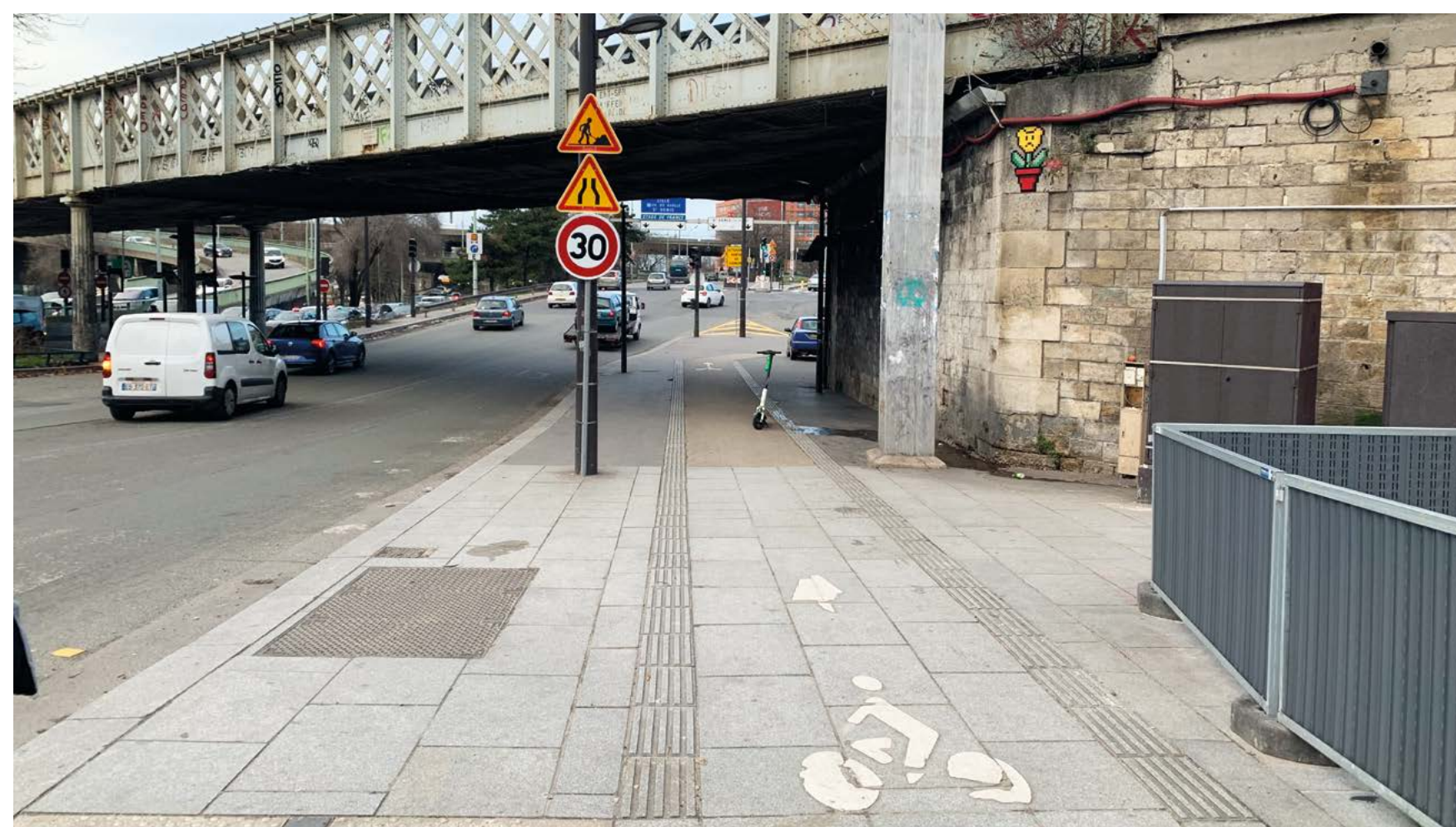
Conflits d'usage entre piéton.ne.s et cyclistes sur le trottoir
