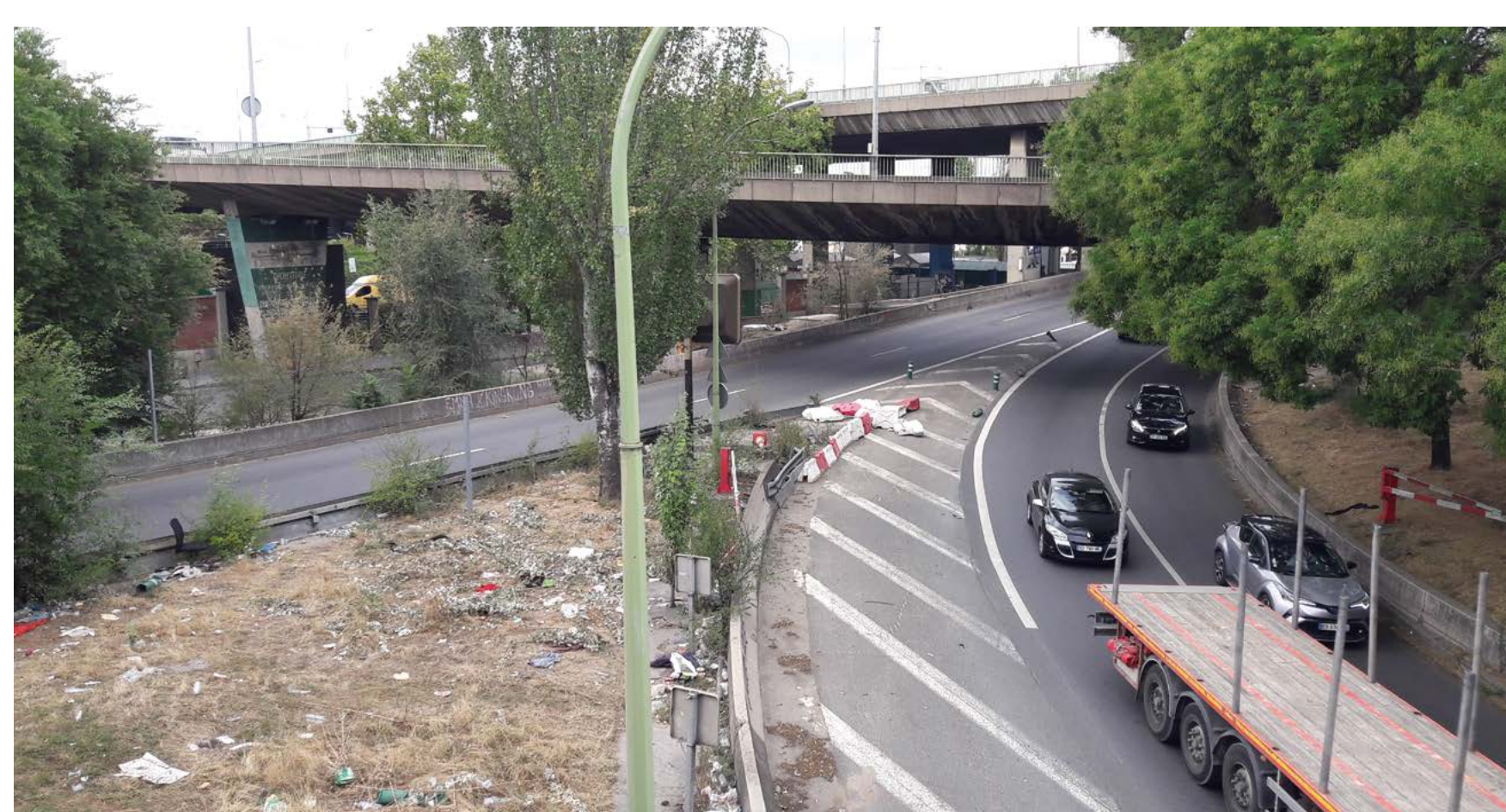
Des talus en friche entre les voies de circulation
