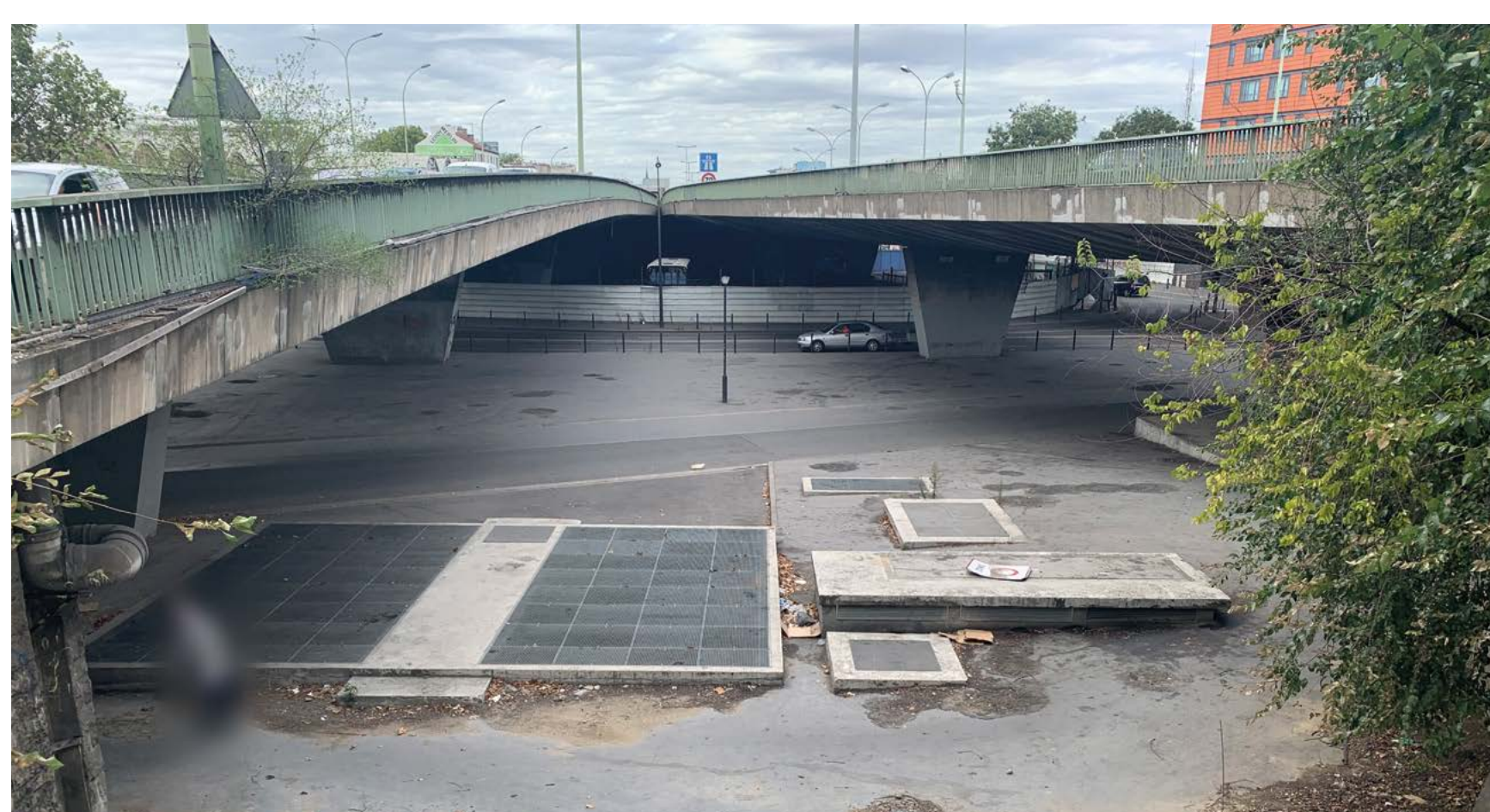
Des émergences techniques occupent l'espace sous les ouvrages
