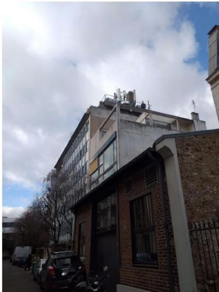
Pas de modification de l'aspect extérieur de l'installation
