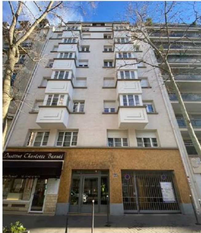
Pas de modification de l'aspect extérieur de l'installation
