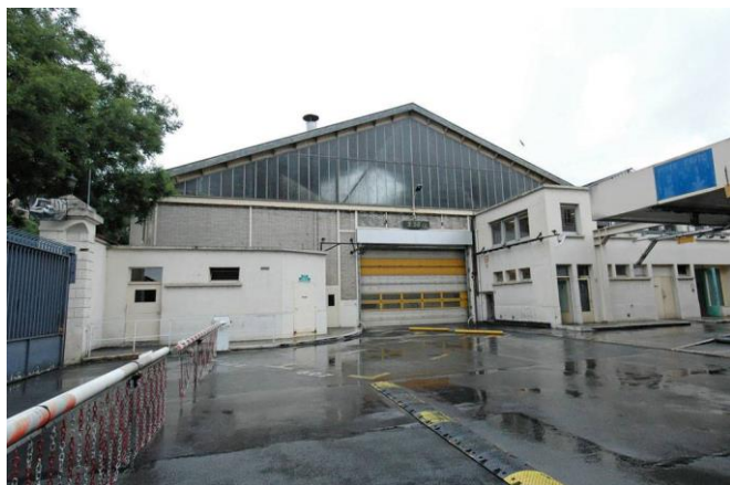
Vue du bâtiment à démolir
