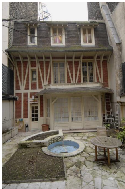
Vue du bâtiment sur cour
