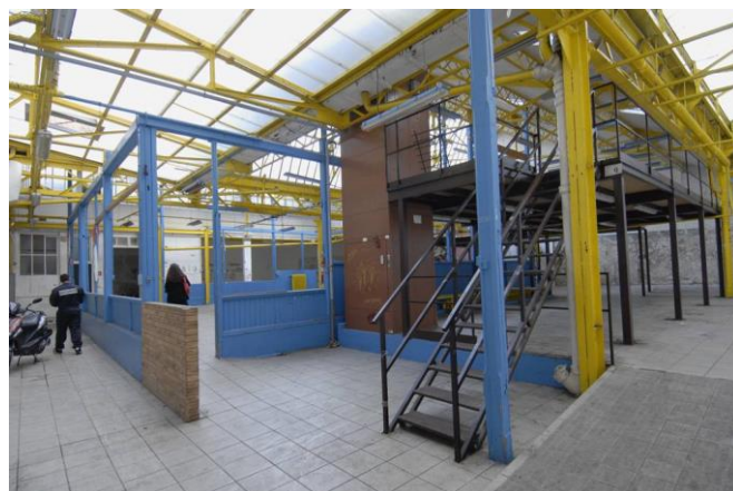
Vue du hangar
