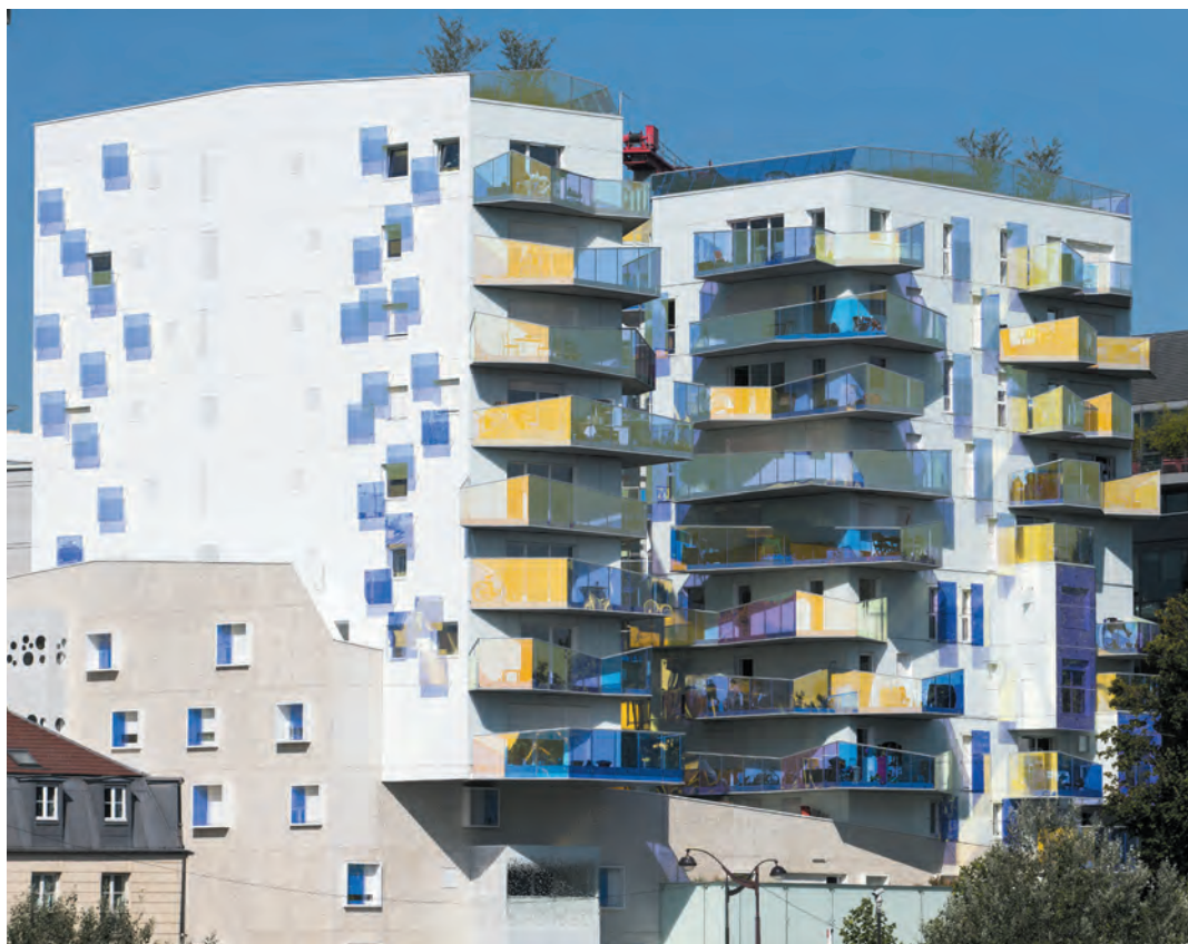
Ilôt Fulton, 13/5 rue Fulton Phase 1 : bâtiment 1 en front de Seine livré en juin 2017. Phase 2 : en cours. 320 logements sont concernés à terme. (Bailleur : ICF La sablière)
