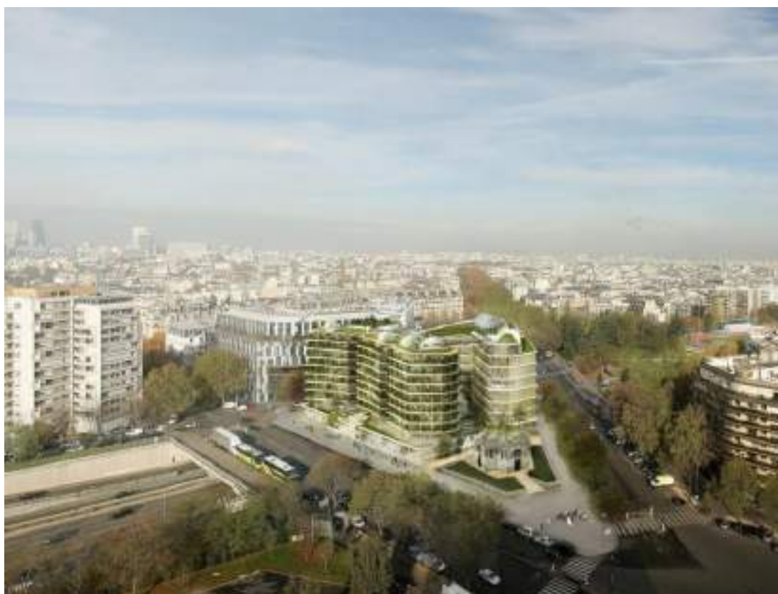
La ville multi strates - Architecte Jacques Ferrier
