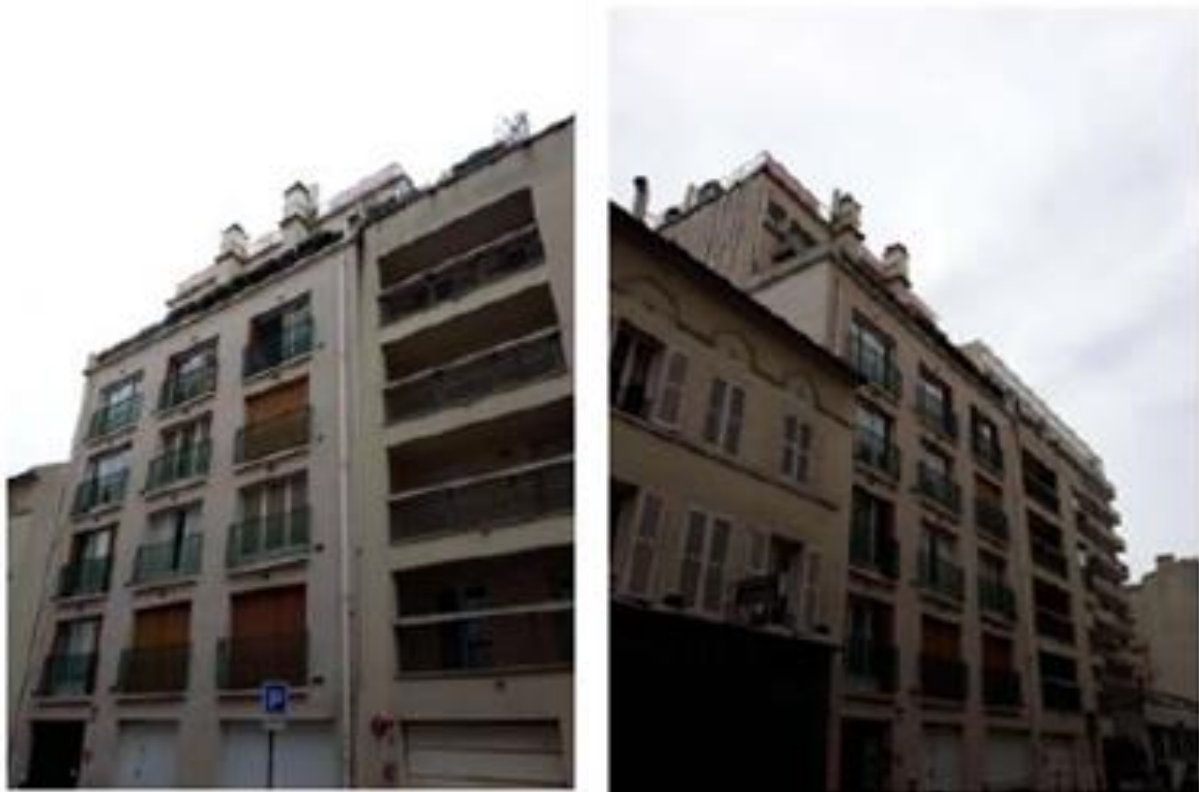
Pas de modification de l'aspect extérieur de l'installation.
