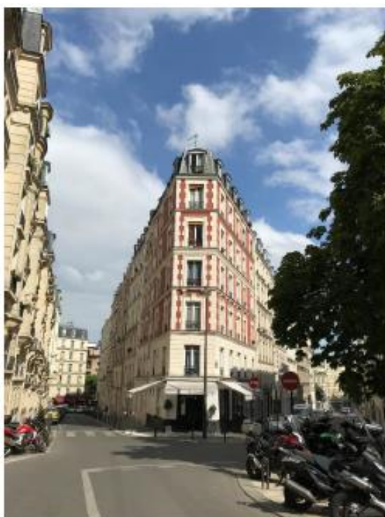
L'installation n'est pas visible depuis ce point de vue
