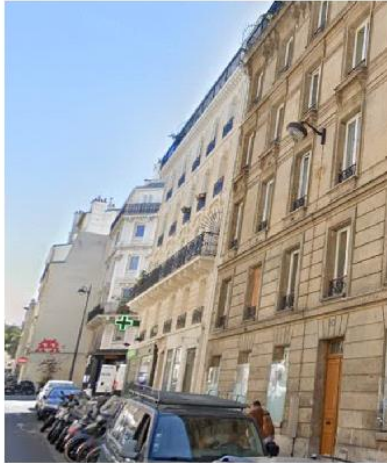
Etat de l'existant : Non visible depuis la rue
