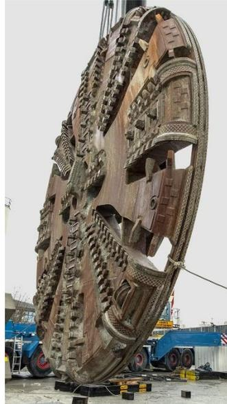
3 – Dépose de la roue de coupe
