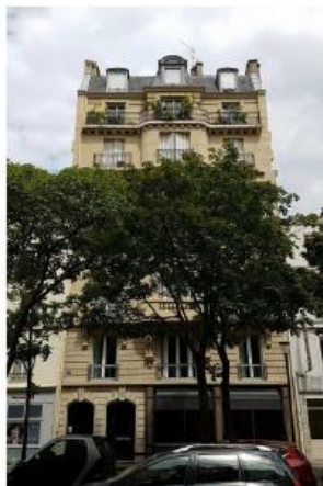
Les antennes ne sont pas visibles de ce point de vue
